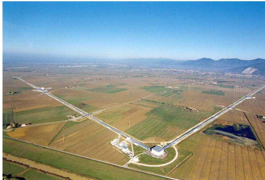
FIGURE 2.1 : Photographie aérienne de Virgo.
