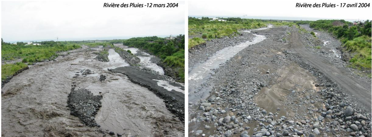
Fig. III-36 : Section intermédiaire de la Rivière des Pluies lors de la crue du 12 mars 2004 et après la décrue le 17 avril 2004
