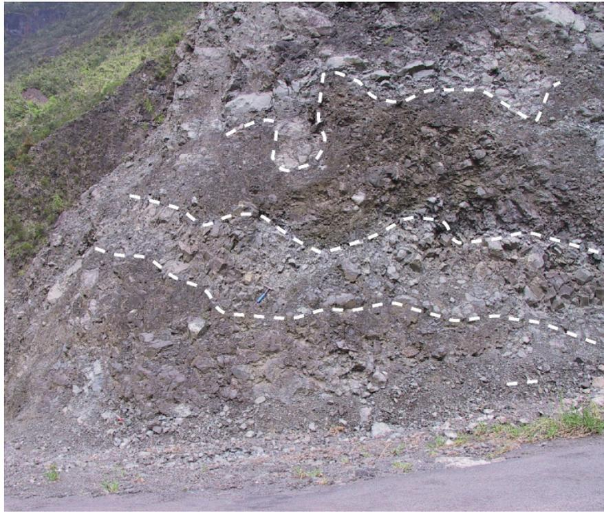
**Fig. II-25 :** Affleurement de dépôts présentant des fantômes de structures, faciès « bloc » typique dans Cilaos sur la route d'îlet à Cordes.
