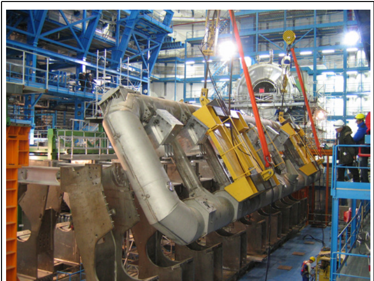
Figure 6.4 : Installation de la première bobine du toroïde dans les pieds, novembre 2004
