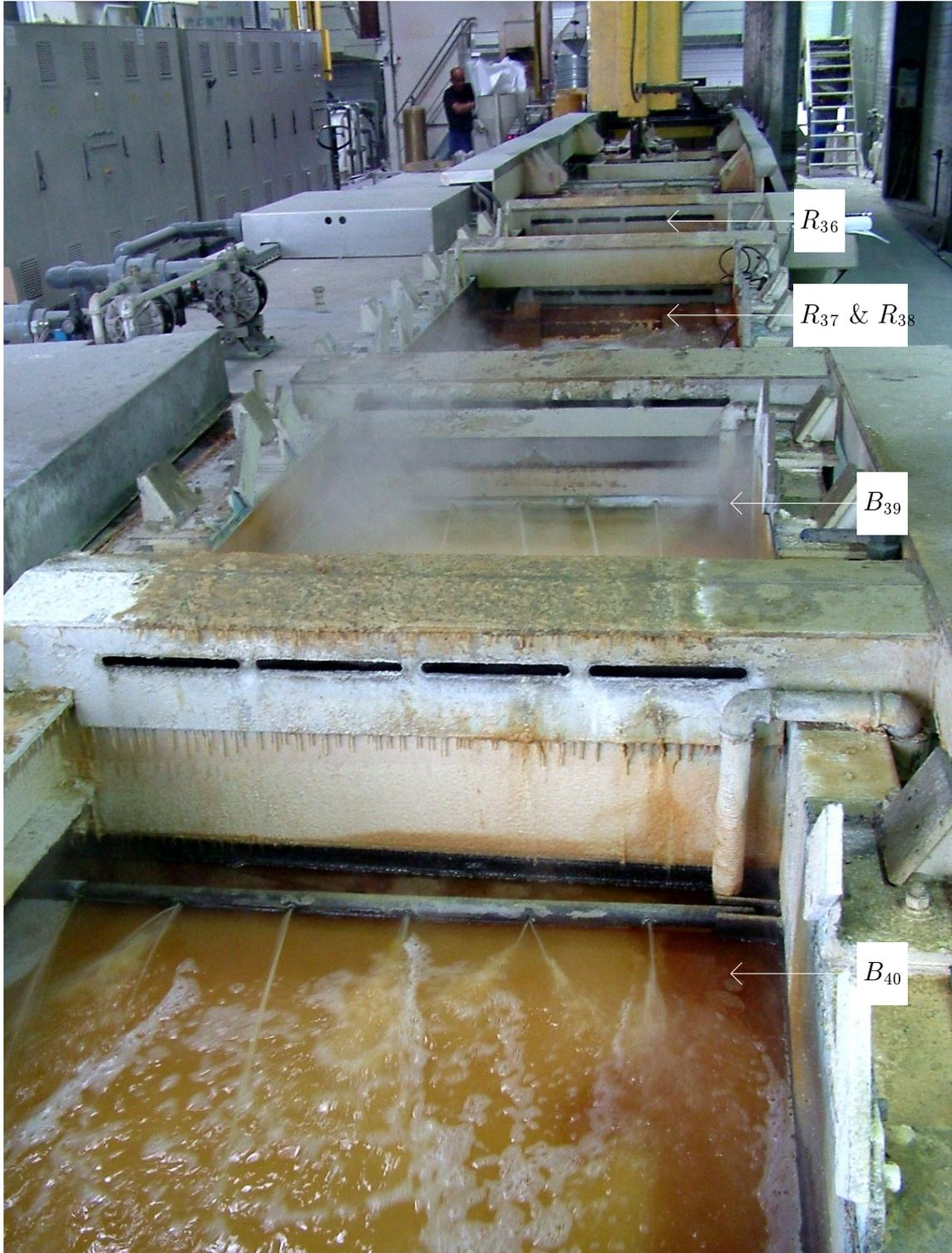
FIG. .2 – L'ensemble des "bains de dégraissage lessiviel alcalin" et des trois rinçages en cascade
