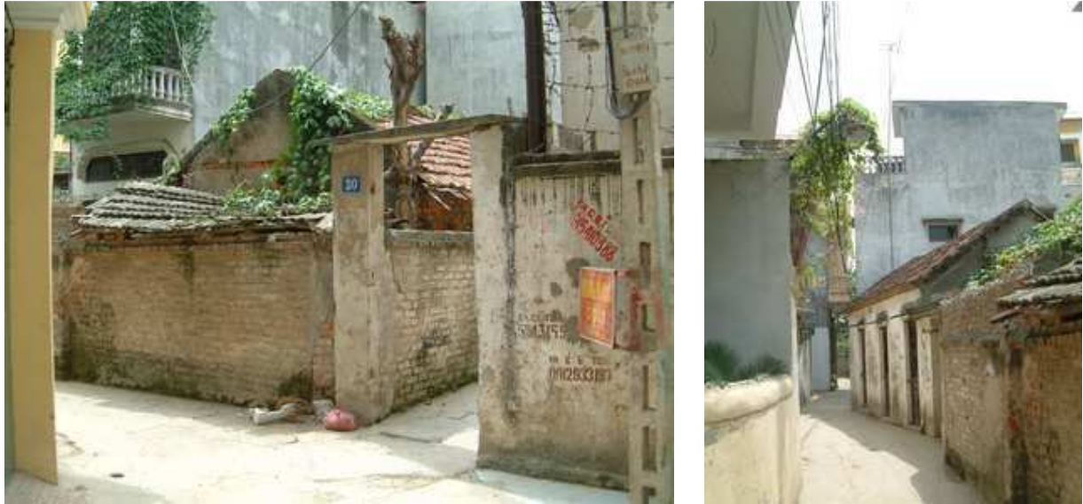
Figure 22. Maisons de quatrième catégorie en dégradation
