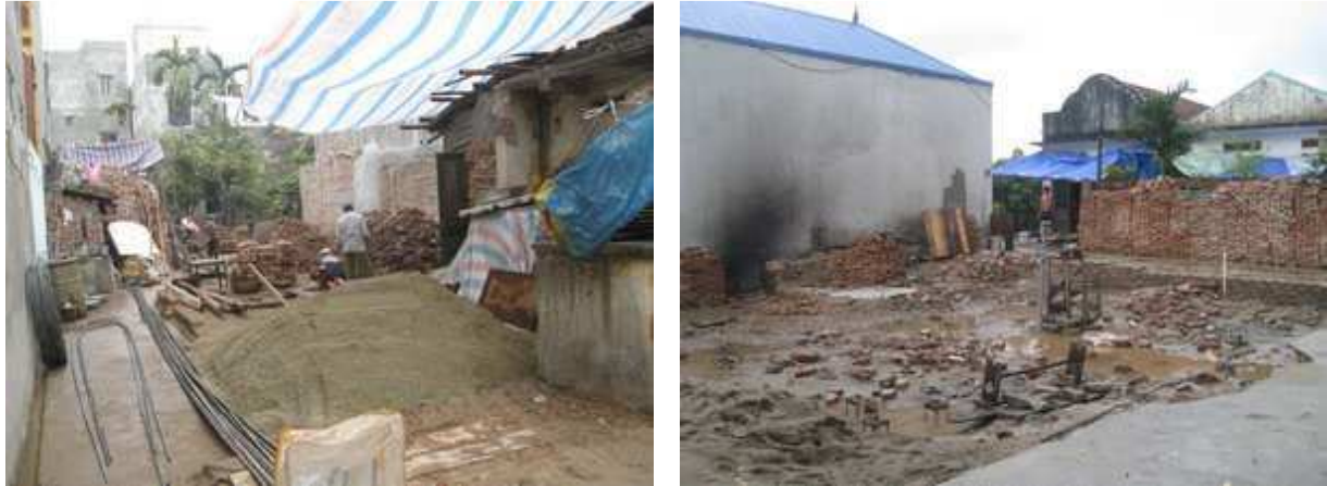
Figure 50. Construction en cours à Yen So
