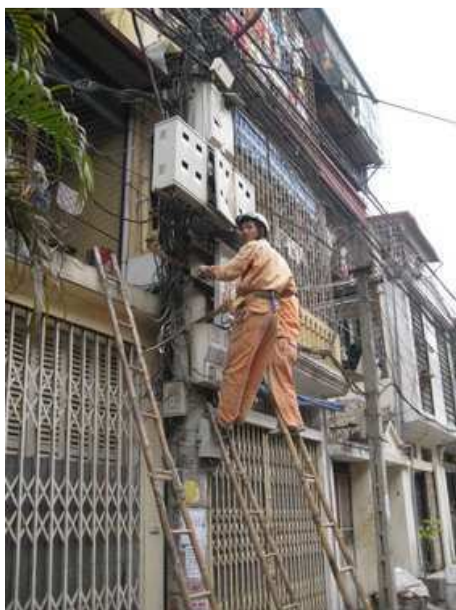
Réparation de réseau électrique à Giap Bat
