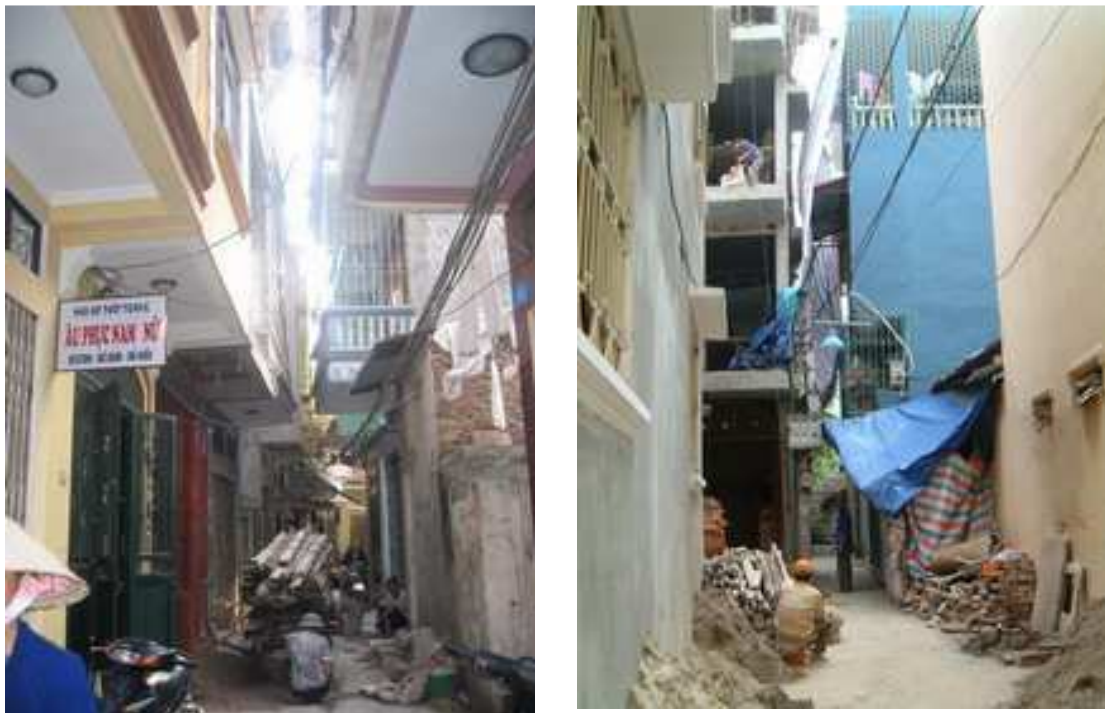
Figure 47. Images de la construction en cours – quartier de Giap Bat
