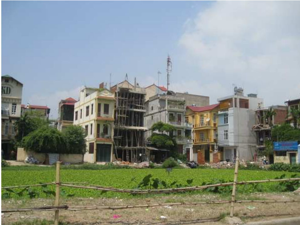
Figure 31. Construction des maisons tubes à Hanoi
