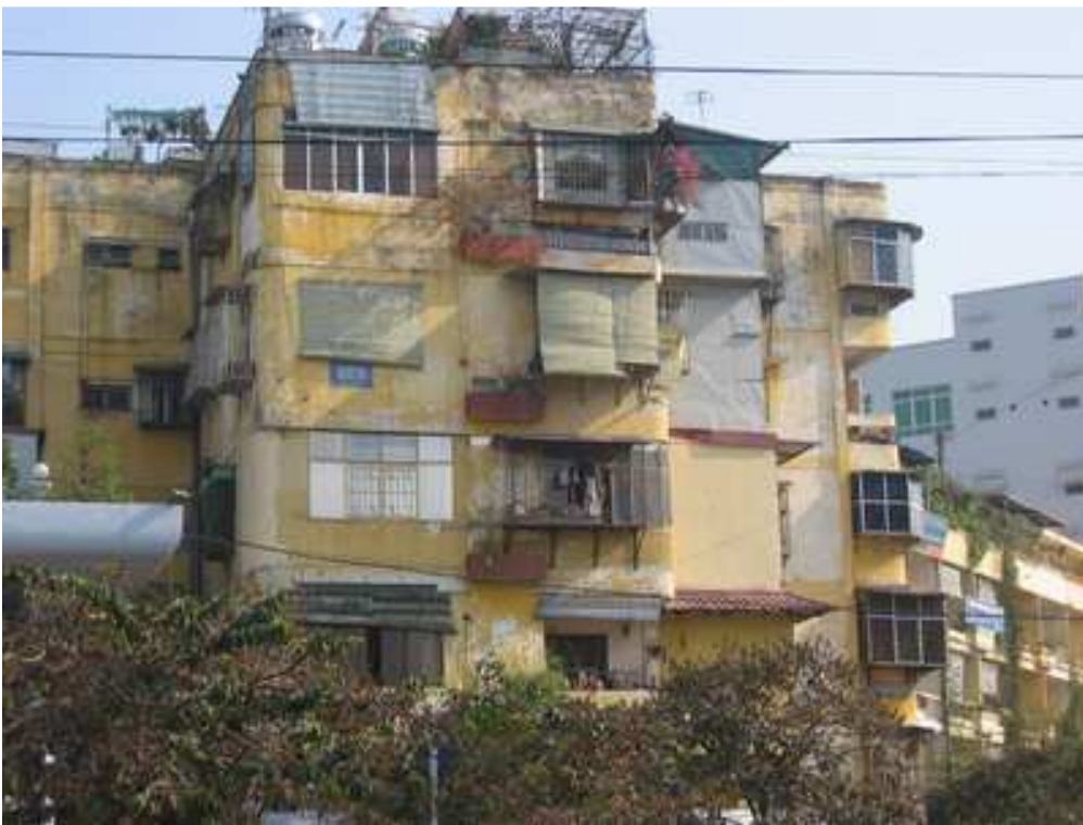
Figure 19. Un immeuble collectif à Giap Bat
