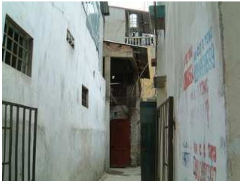
Figure 139. Construction envahissante le terrain (privatisation d'une ruelle)
