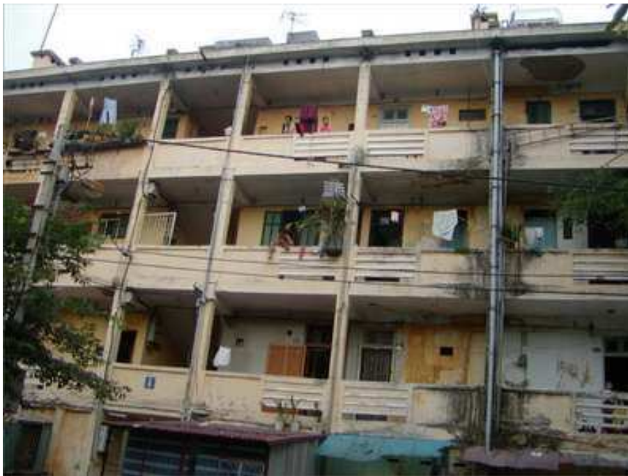
Figure 18. Façade d'un khu tập thể à Hanoi
