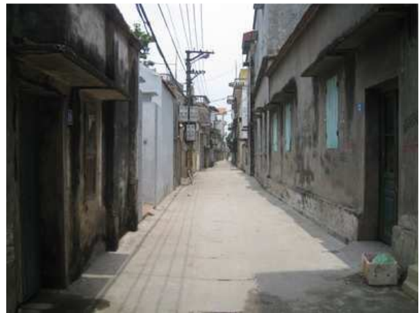
Une ruelle améliorée récemment à Yen So – 08/2009 (à partie de l'ancien système ouvert)
