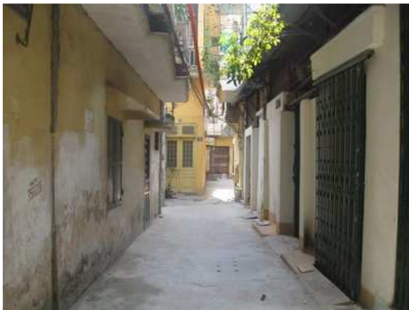
Ruelle Hoa Binh à Van Chuong, deux mois après les travaux
