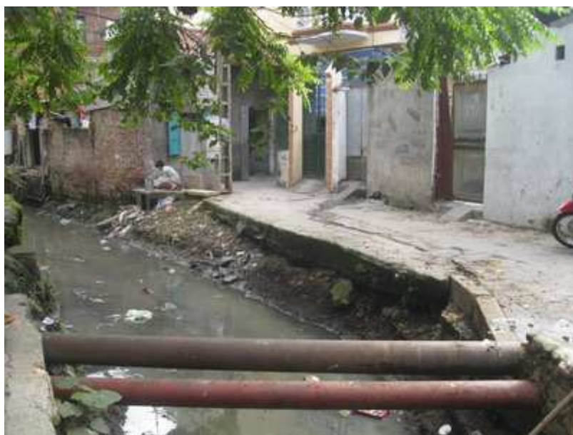
Figure 58. Tuyaux principaux d'eau courante à Hanoi
