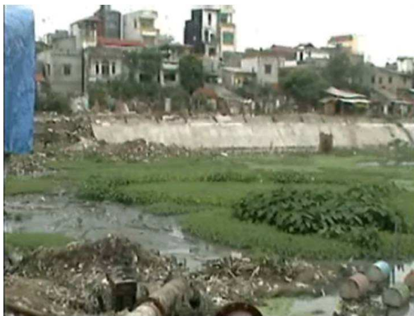
Projet en cours (2004)
