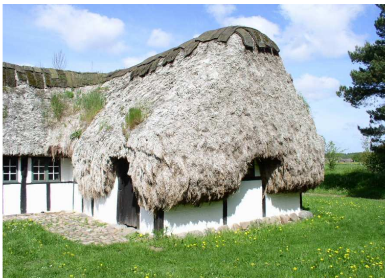
FIGURE 4 – Maison danoise au toit de Zostera marina , photographie J. Borum, (Terrados & Borum, 2004)
