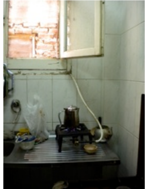
Illustrations 6 et 7. Dispositif de transformation des déchets organiques en gaz, et récupérateur de compost liquide et arrivée du biogaz dans la cuisine du ménage équipé.
