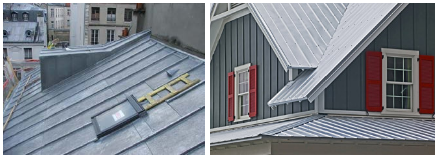
FIGURE 2.25 – Toitures en zinc
