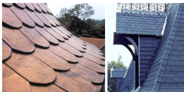
FIGURE 2.23 – Toitures en bardeaux d'asphalte
