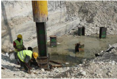
FIGURE B.15 – Opération de battage de pieux en acier (illustration : http://www.eccomarhaiti.com )
