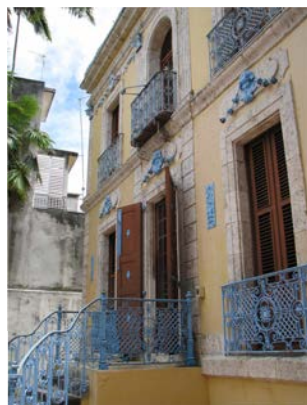
FIGURE 10.11 – Musée Schoelcher à Pointe-à-Pitre, Guadeloupe : bâtiment en calcaire s'élevant sur deux niveaux, ossature réalisée avec des pierres de taille appareillées qui structure des remplissages frustres
