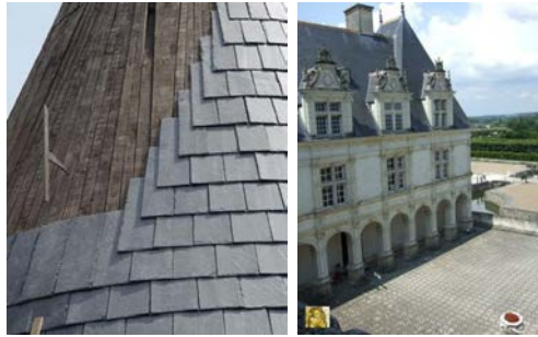
FIGURE 2.24 – Toiture en ardoise
