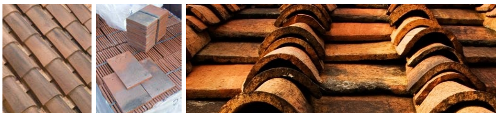
FIGURE 2.26 – Tuiles «canal», tuiles plates, tuiles à emboîtement
