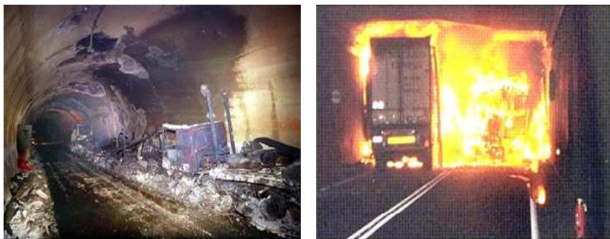
Fig.0.1 - Photographies de cas d'incendie dans un tunnel [w1]
