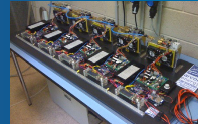
Système Arcola Energy (5 générateurs PEMFC) Projet EU MOBYPOST
