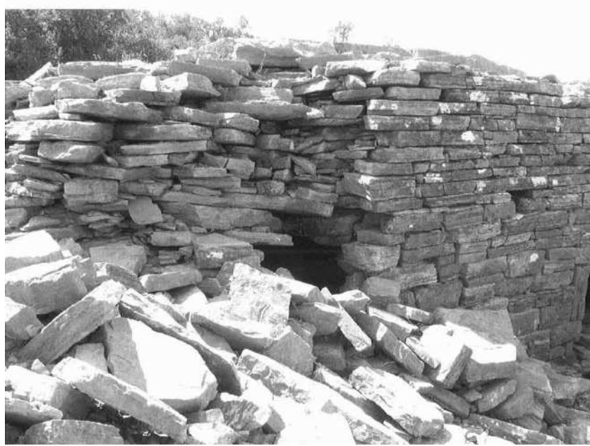
Fig. 168. Alâzetin Kalesi. Bâtiment 31. Plattenmauerwerk (Rumscheid, 2009, fig.3)
