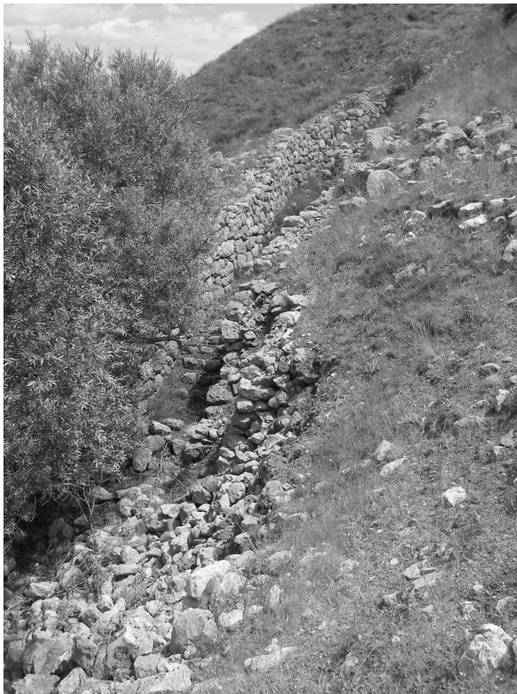
Fig. 73. Boğazköy. Büyükkale. Escalier sur la pente nord (ph. l'auteur)
