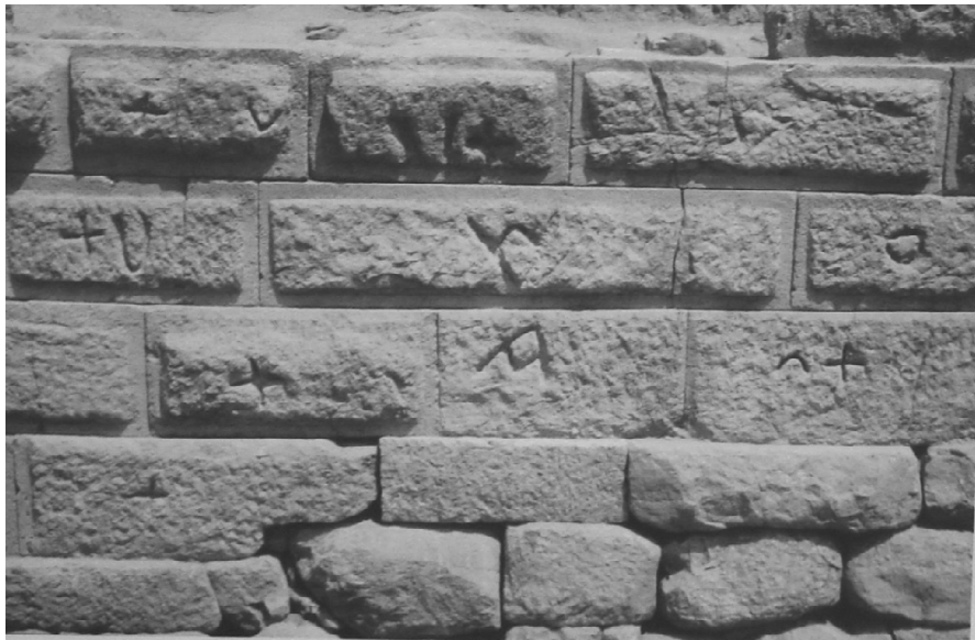
Fig. 146. Sardes. Secteur MMS. Détail des blocs à ciselure périmétrale (Cahill, 2010(a), fig.13)
