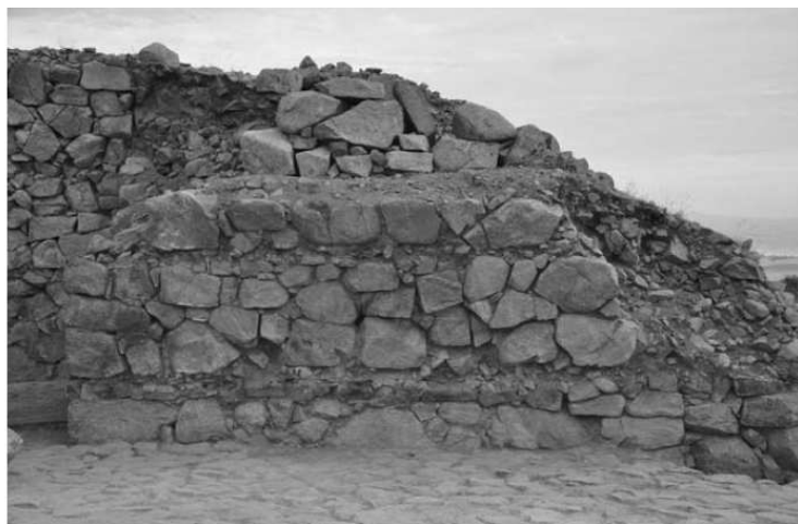
Fig. 106. Kerkenes. Mur avec empreintes de poutres Summers et al. , 2010, fig. 106)
