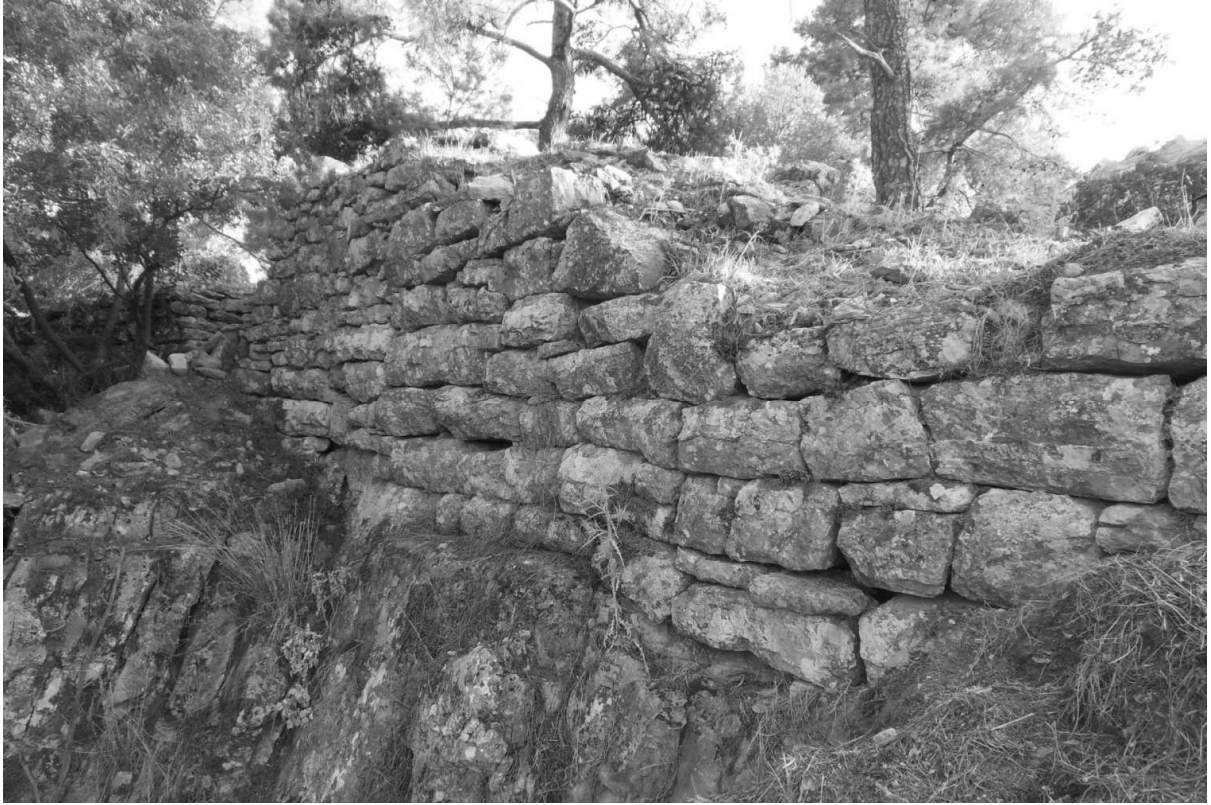
Fig. 164. Gökçeler-Pédasa. Mur de l'acropole. Façade extérieure (ph. de l'auteur)
