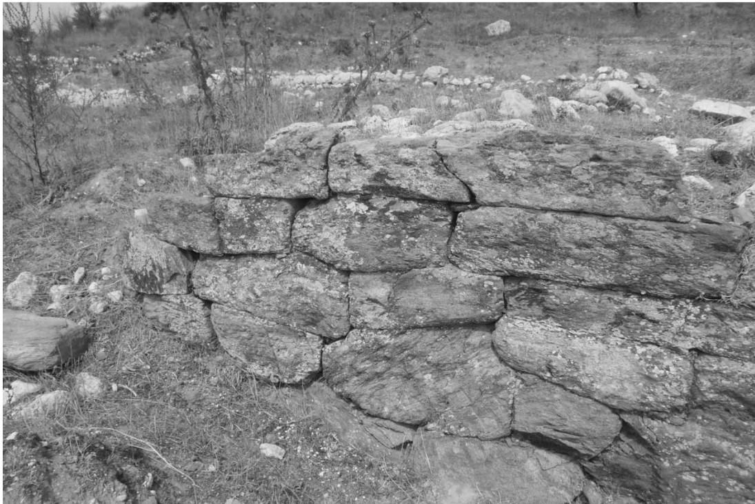
Fig. 212. Milet. Kalabaktepe. Mur en appareil polygonal (ph. de l'auteur)
