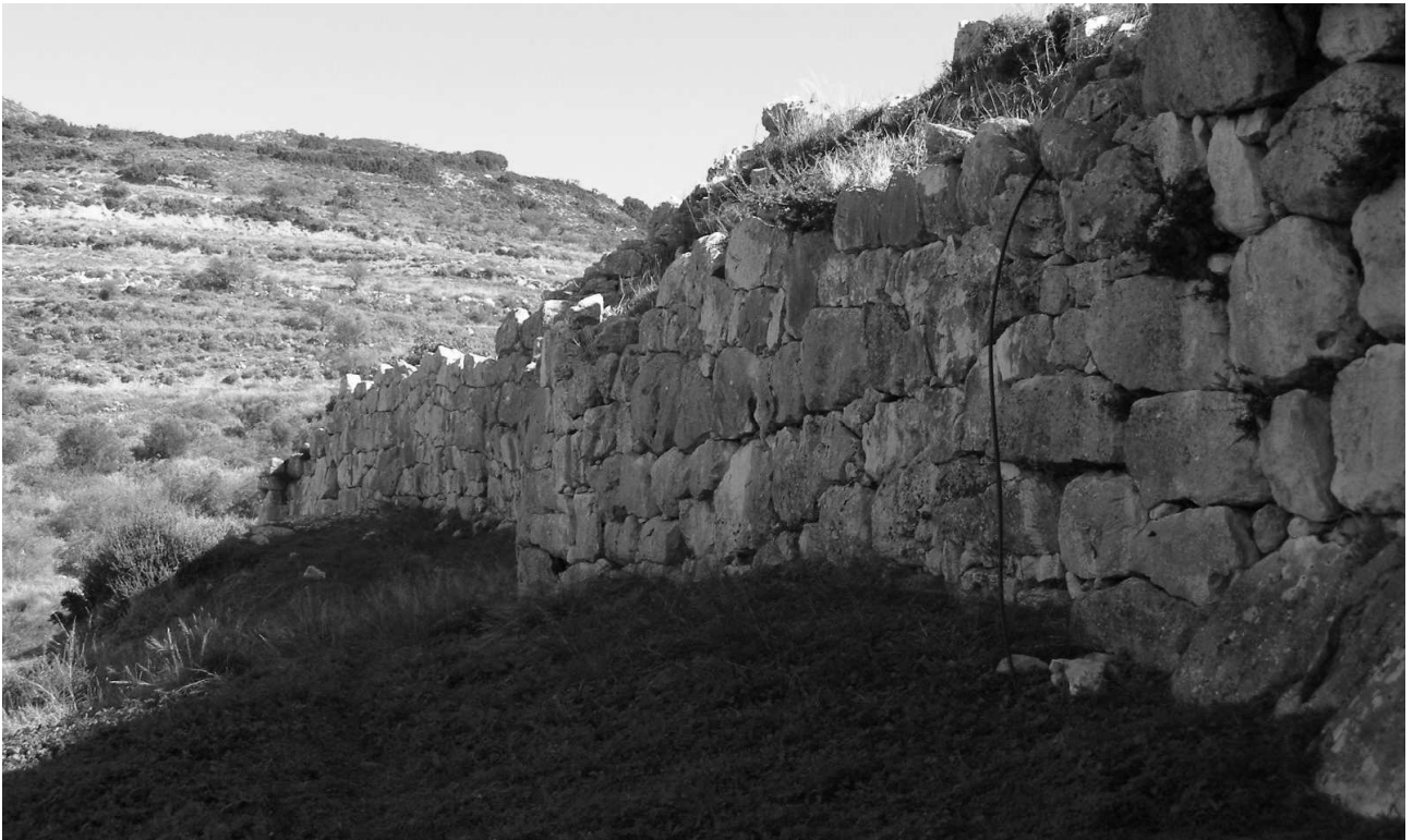
Fig. 363. Mycènes. Citadelle. Section en appareil cyclopéen (ph. de l'auteur)
