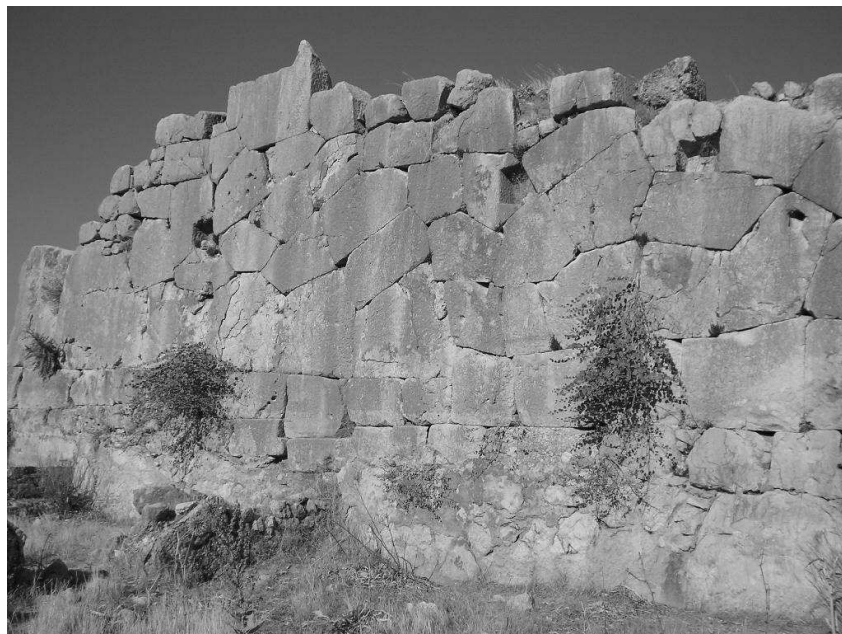
Fig. 381. Xanthos. Parement Est de l'enceinte de l'acropole lycienne. Appareil polygonal lesbien (ph. de l'auteur)
