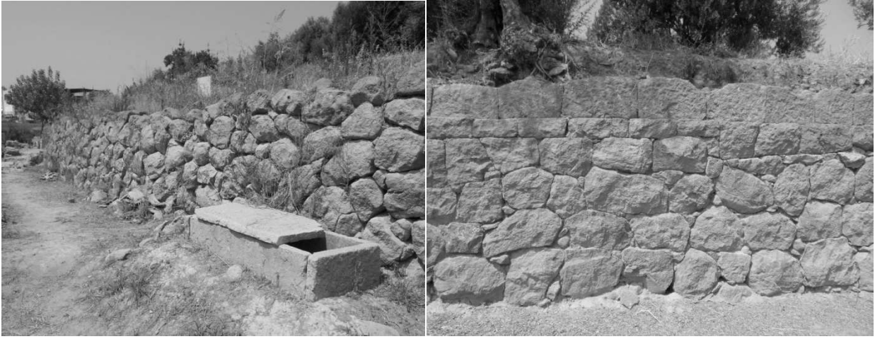
Fig. 254-255. Smyrne. Murs du VII e s. et du couronnement en appareil polygonal lesbien (VI e s.) (ph. de l'auteur)
