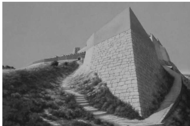
Fig. 353. Troie VI. Bastion N-E
