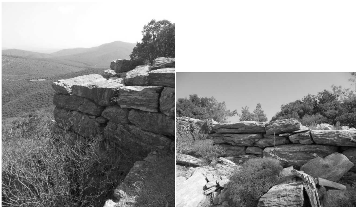
Fig. 188. Théangéla. Appareillage des murs (Ph de l'auteur)
