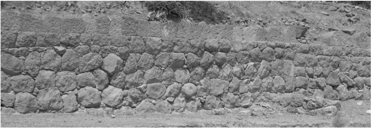
Fig. 256. Smyrne. Socle du VII e s. et superstructure en appareil polygonal lesbien (VI e s.) (ph. de l'auteur)
