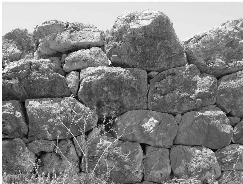
Fig. 193. Myndos. Mur de la péninsule. Appareil polygonal (ph de l'auteur)
