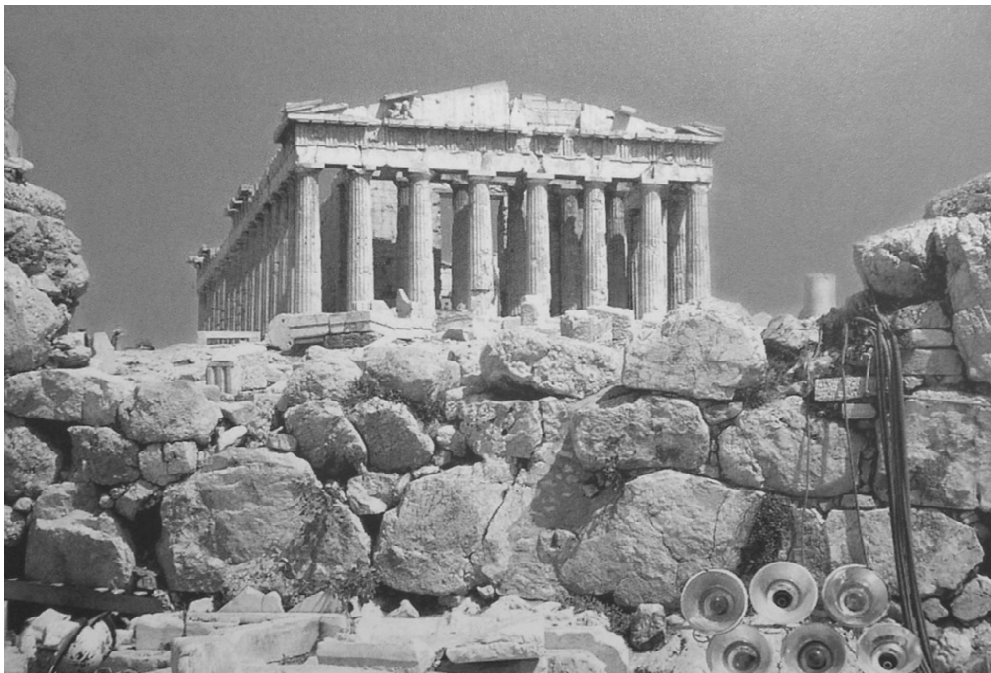
Fig. 368. Athènes. Mur mycénien. Appareil polygonal (Iakovidis, 1983, pl. 19a)
