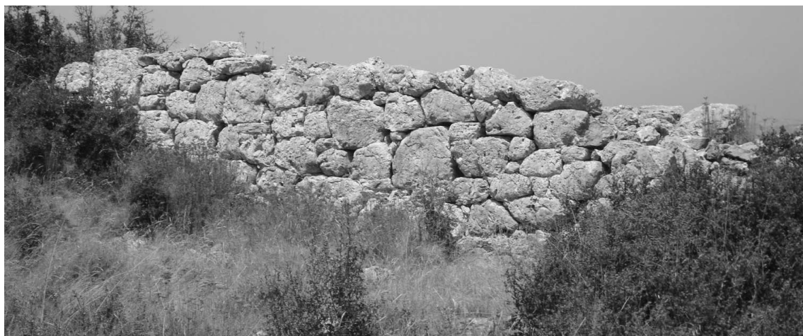
Fig. 226. Samos. Section du rempart nord. (ph. de l'auteur)
