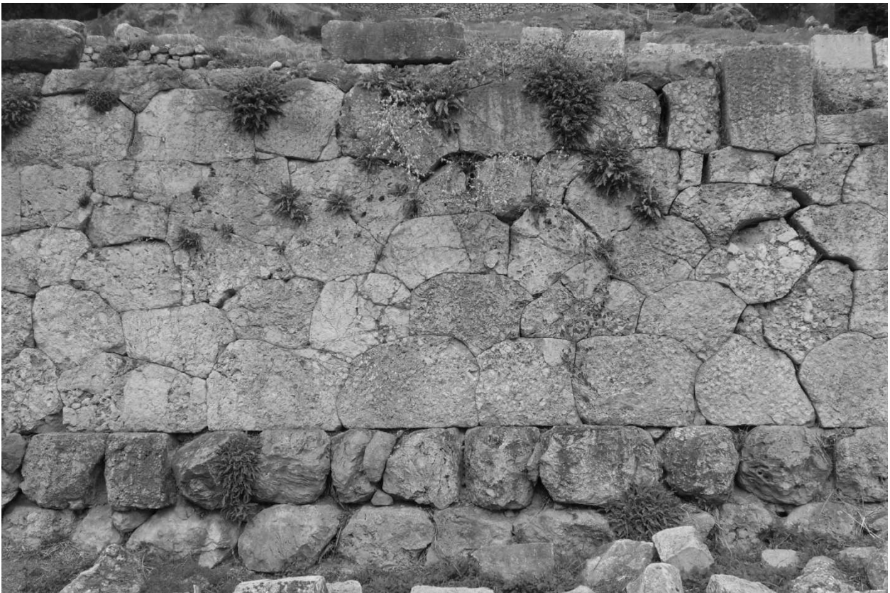
Fig. 390. Delphes. Mur en appareil polygonal à joints courbes (ph. de l'auteur)
