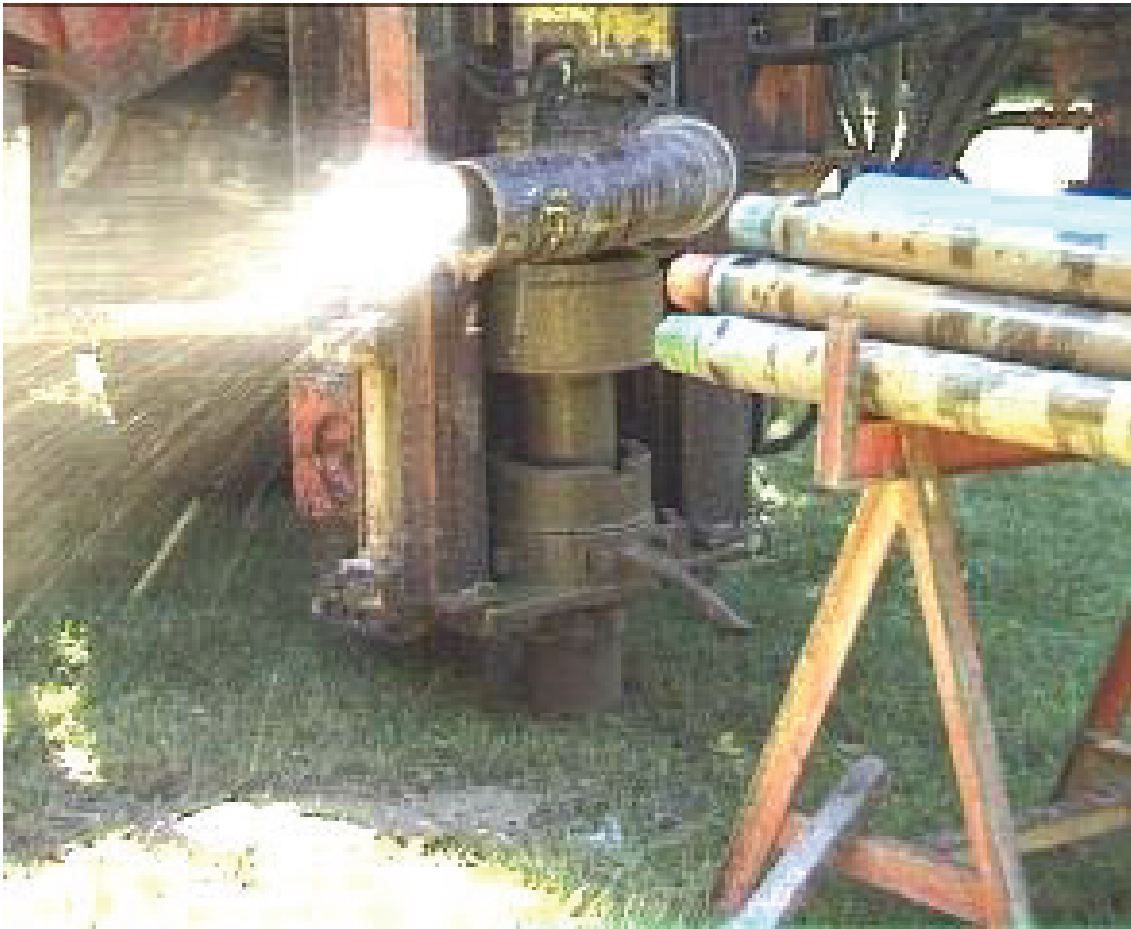
Figure 103 : Foration Odex à l'air comprimé
