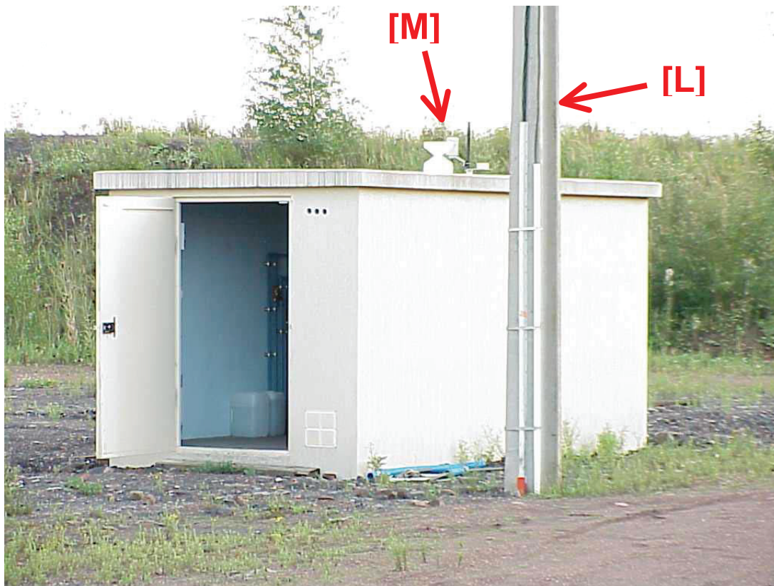
Figure 62 : Local d'analyse [M] : station météo sur le toit [L] : lignes 380 V et télécom
