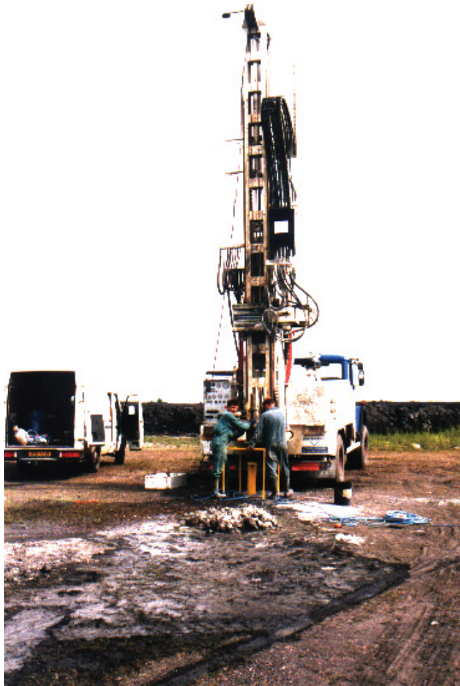
Photo 5 : Foration et installation de piézomètres
