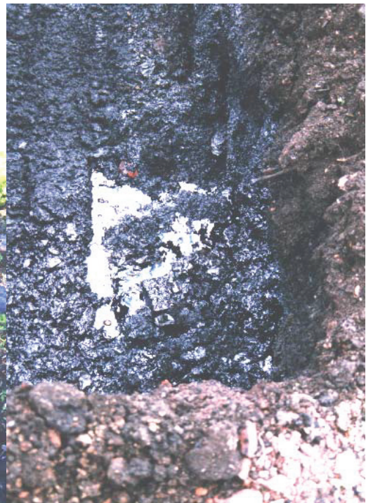
Photo 4 : Sondage à la pelle mécanique (goudron liquide à 80 cm de profondeur sur A3).
