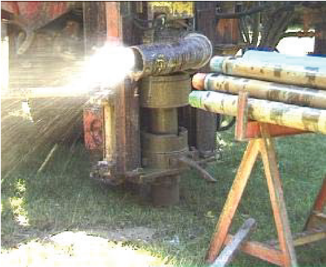
Figure 103 : Foration Odex à l'air comprimé
