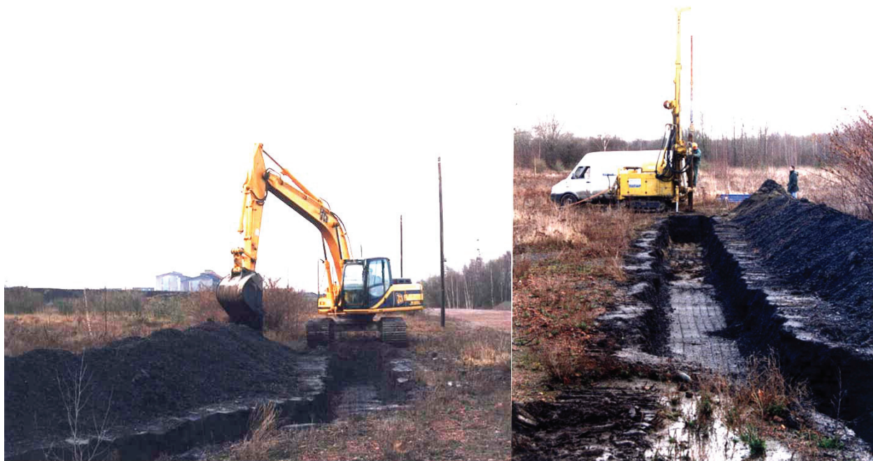
Figure 65 : Réalisation des tranchées à la pelleuse pour l'enfouissement de la conduite de refoulement et de l'alimentation électrique
