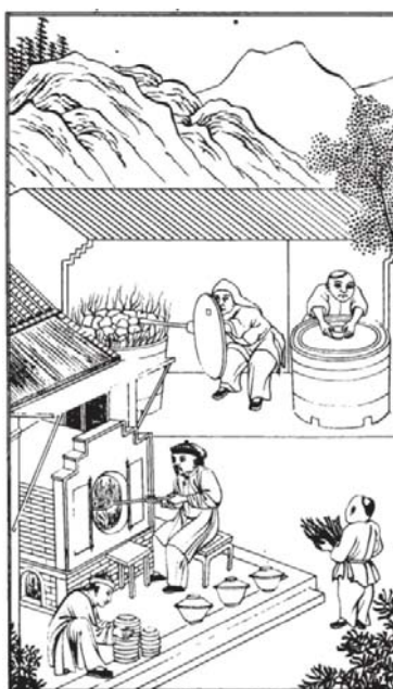
Figure 286 : Deuxième cuisson pour les émaux. Illustration : Jīngdézhèn táolù túshuō 景德镇陶录图说 (Recueil illustré sur la céramique de Jingdezhen), 1815.
