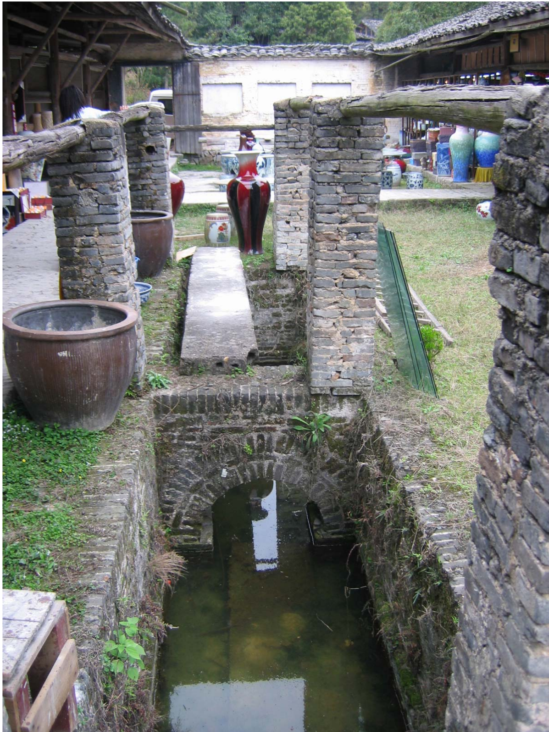
Figure 311 : Bassins de stockage de l'eau de pluie, Jingdezhen, 27 mars 2008. Photographie : N. Balard.
