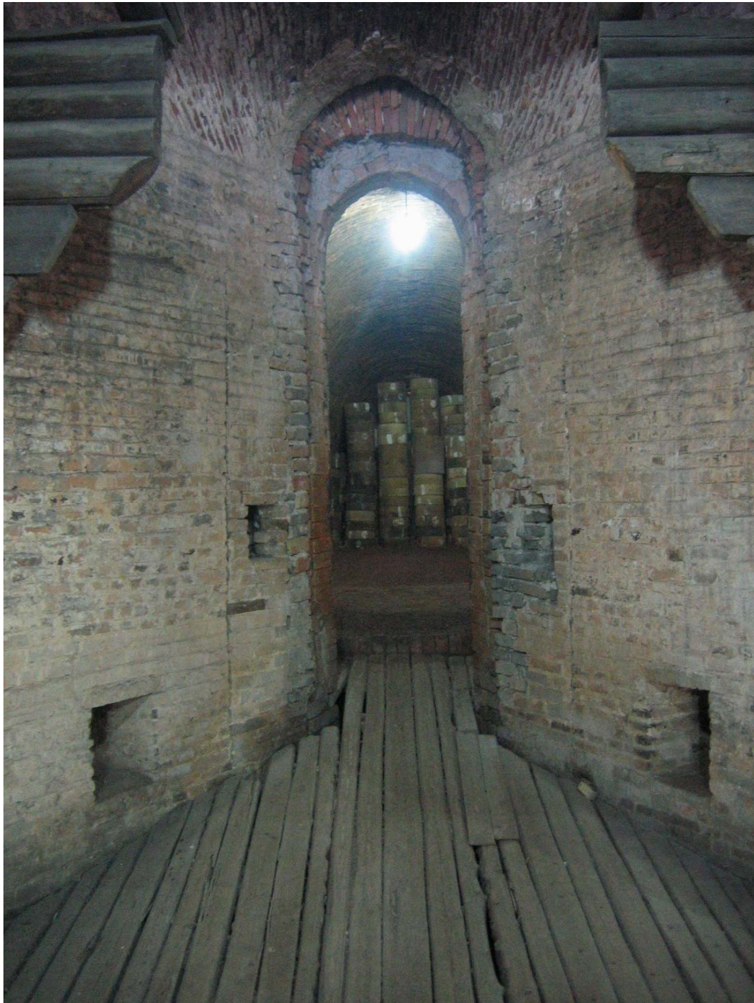
Figure 323 : Devant l'ouverture de la chambre de cuisson d'un four de Jingdezhen, vue de l'intérieur avec les cassettes empilées, Jingdezhen, 20 octobre 2006. Photographie : N. Balard.
