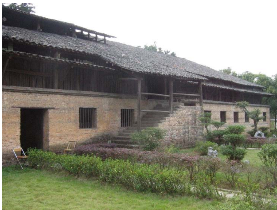
Figure 319 : Vue extérieure d'un ancien four de Jingdezhen, escalier pour monter à l'étage, Jingdezhen, 20 octobre 2006. Photographie : N. Balard.
