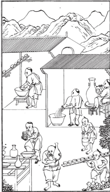
Figure 269 : La pose de la couverte. Illustration : Jingdézhen táolù túshuō 景德镇陶录图说 (Recueil illustré sur la céramique de Jingdezhen), 1815.
