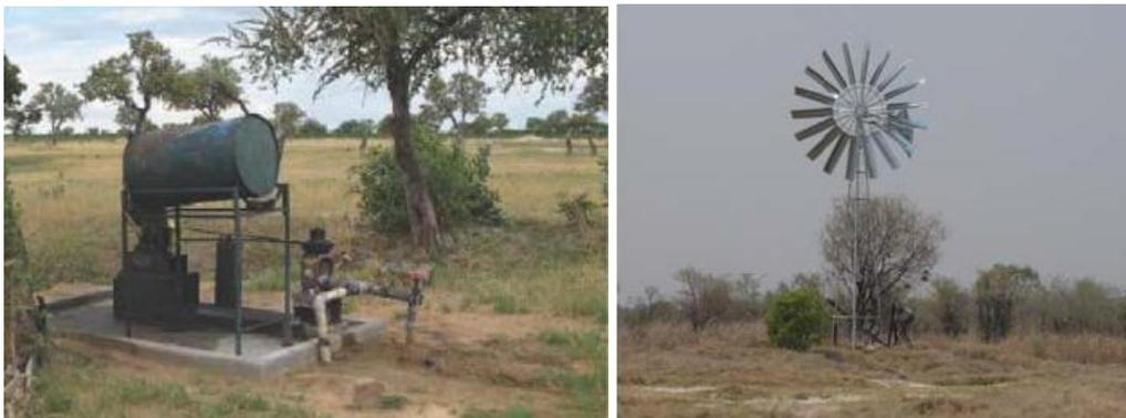
**Fig A.3.9 : Deux types de pompes : à gauche une pompe diesel, à droite une pompe éolienne. Source : (Le Pic Vert 2011)**
