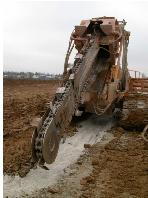
Figure 6 Vue de face de la trancheuse Solétanche-Bachy en attente avant début des travaux
