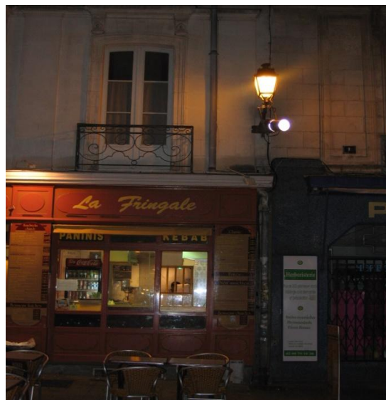
Mise en place de projecteurs puissants
