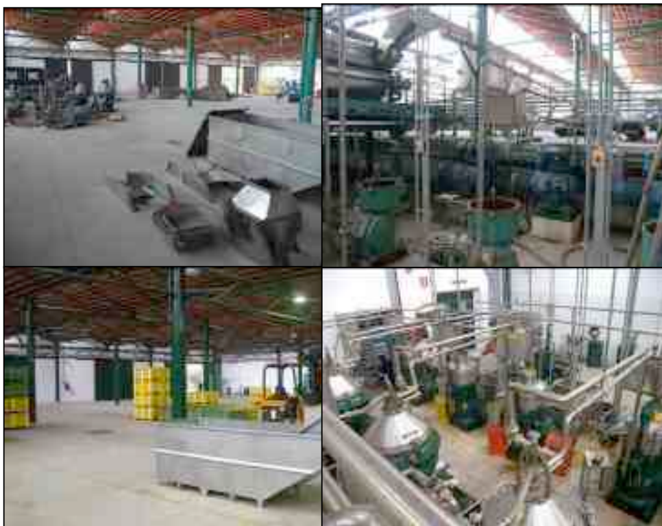
Photos 154 et 155 (haut) – Anciennes installations du Consortium Photos 156 et 157 (bas) – Installations modernes du Consortium © 2009, 2011 RM
