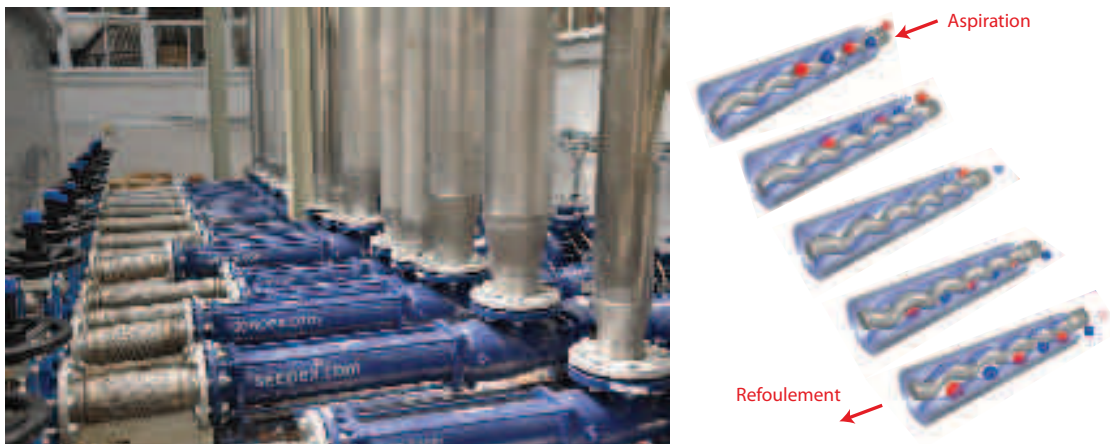
FIGURE 4.5 – A gauche : photo des pompes volumétriques. A droite : Schéma de fonctionnement des pompes réalisé à l'aide de capture d'écran de l'animation disponible sur http://www.youtube.com/watch?v=12Wszv1wUMk&feature=related .
