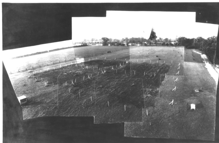
FIGURE 1.20 – Réseau de dipôles à Jodrell Bank, avec des scintillateurs, en 1967 (l'expérience initiale de 1965 utilisait 3 compteurs Geiger-Müller).
