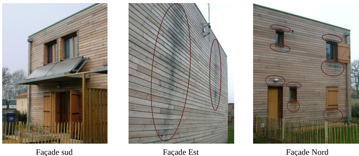
Figure 3.59 : Vues des façades extérieures du logement J et identification des marques d'humidité
