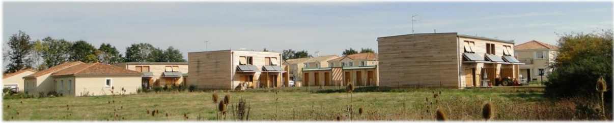
Figure 3.40 : Vue extérieure générale de la résidence Guy de Maupassant à Fontaine le Comte
