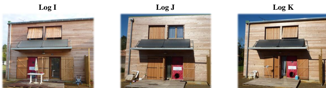
Figure 3.38 : Vues extérieures des trois logements étudiés lors du test d'étanchéité à l'air
