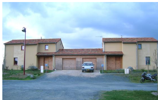
Façade nord : T4 à gauche et T3 à droite
