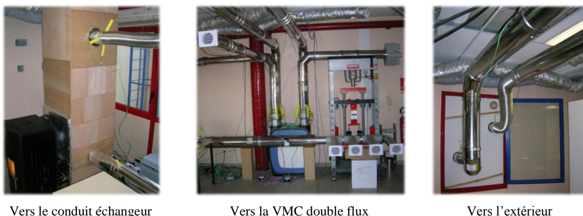
Figure 3.9 : Vues du réseau de ventilation lors des essais en laboratoire
