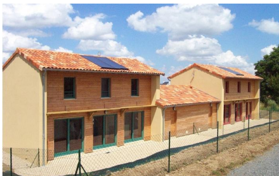
Façade sud : T3 à gauche et T4 à droite
