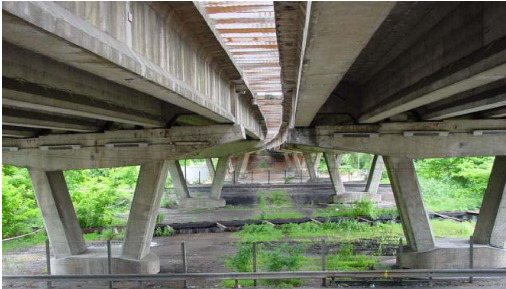
Figure 4.60. Viaduc de Merlebach.
