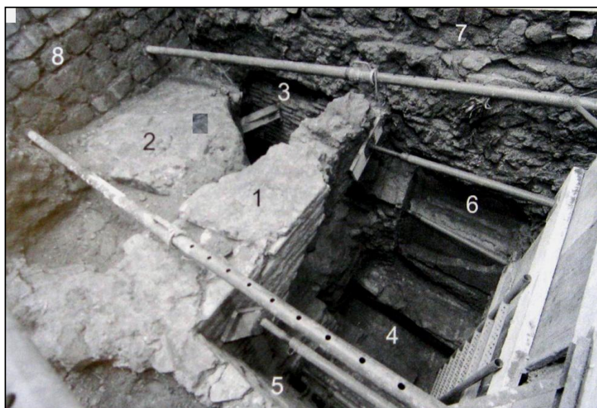
Figure 128 : Sondage effectué en 2005 dans le jardin inférieur du Couvent de la Trinité des Monts. 1 : Mur et arc du prae-furnium ; 2 : Bloc de voûte effondré du local du prae-furnium ; 3 : Mur de façade du complexe ; 4 : Canal de chauffe de l'hypocauste ; 5 : Côte est de la vasque avec tubuli ; 6 : Côte ouest de la vasque ; 7-8 : Structures modernes du jardin (Broise Jolivet 2005)
