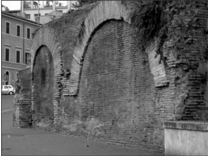
**Figure 133** : Structures du *balneum* ( ?) en *opus latericium* encore visibles sur la via del teatro di Marcello (cliché A. L. Foulché)
