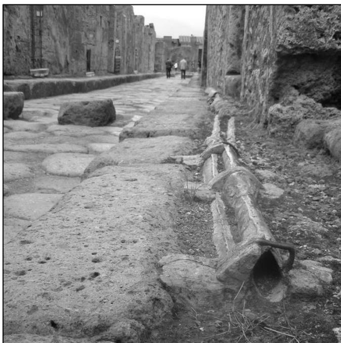
**Figure 30** : Réseau de *fistulae aquariae* desservant des propriétés privées de Pompéi (cliché A.L. Foulché)
