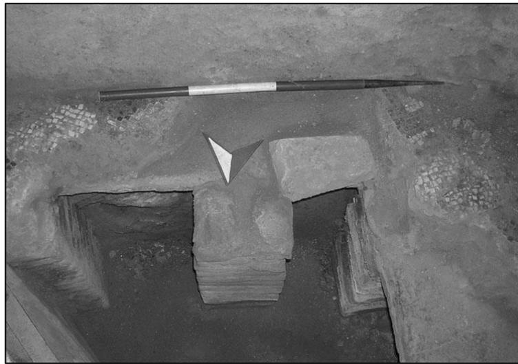
**Figure 27:** Hypocauste encore visible (et en partie reconstruit par P. Germano) dans l'angle sud-ouest de la pièce principale du *balneum* de l'*insula celimontana* (cliché A. L. Foulché)
