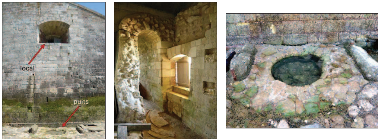
Figure IV-57 : Photographies actuelles du fort Enet. A gauche : vue du mur d'enceinte sur lequel était accolé le puits de tranquillisation. Au centre : casemate ayant accueilli l'observatoire. A droite : base du puits de tranquillisation, quasiment obstrué.
