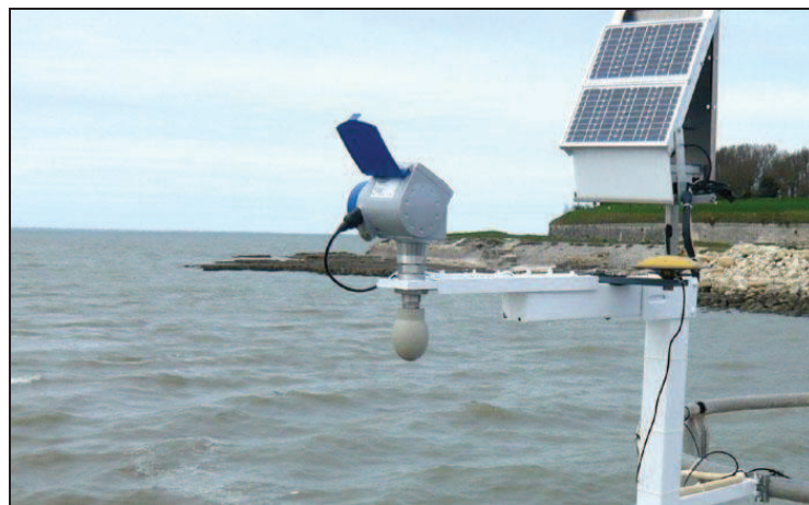
Figure I-6 : Marégraphe radar à air libre, sans puits de tranquillisation. Île d'Aix, 2011.
