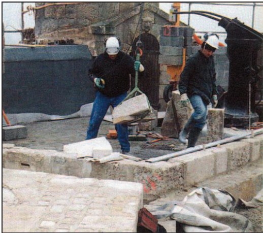
Figure IV-36 : Recomposition des plates-formes de la terrasse du fort Boyard après avoir posé une couche d'étanchéité en dessous. Les pierres reposées sont les pierres d'origine et la marge de tolérance est d'un centimètre par rapport aux cotes initiales [Cettour, 1999].
