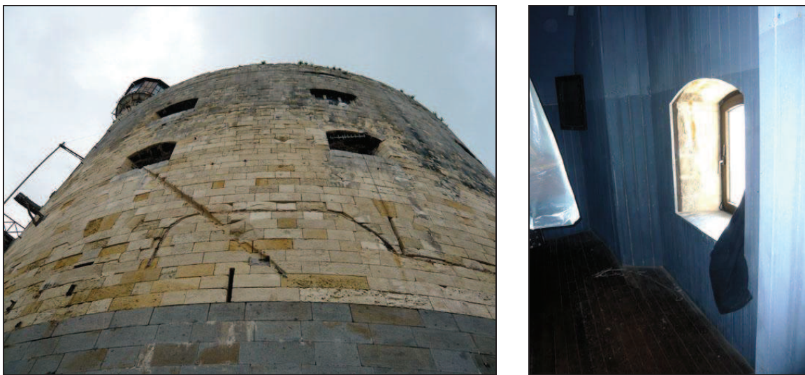
Figure IV-61 : Photographies actuelles du fort Boyard. A gauche : vue du mur d'enceinte sur lequel était accolée la jetée nord du barachois. On aperçoit, dans le mur, la tranchée par laquelle passait le câble de transmission entre le flotteur et le tambour enregistreur. A droite : casemate du marégraphe (n°118).
