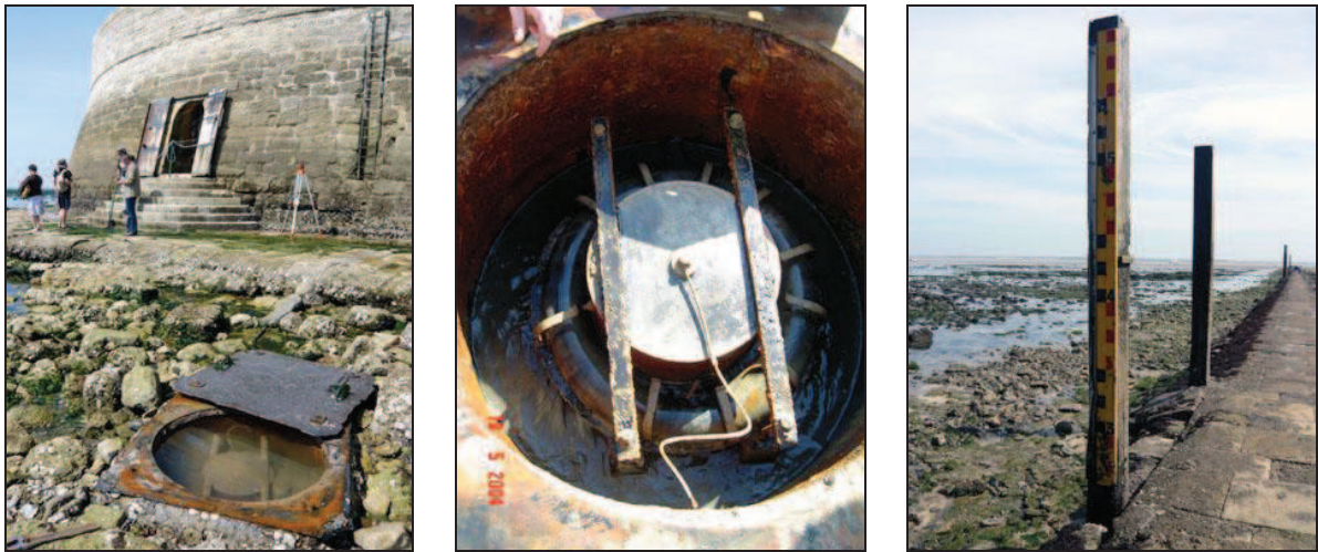
Figure IV-79 : A gauche : emplacement du capteur de pression du marégraphe, situé à une dizaine de mètres à l'extérieur du phare de Cordouan. Au centre : capteur de pression, recouvert d'une plaque métallique en temps normal. A droite : échelle de marée du phare, installée le long du Perrat.
