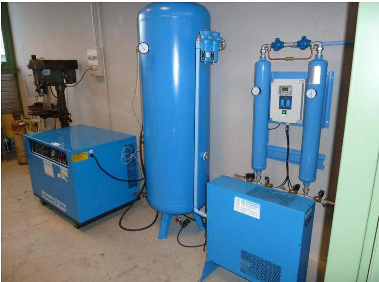
**Figure V-30 : Compresseur d'air et son système de purification**
