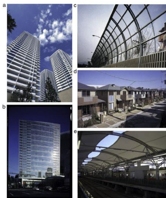
Figure 1.10. Utilisation de matériaux de construction ayant des propriétés auto-nettoyantes au Japon : (a) Tours MM, Yokohama couvertes avec des tuiles auto-nettoyantes ; (b) Bâtiment Matsushita Denso couvert avec des verres auto-nettoyants ; (c) parois insonorisées auto-nettoyantes; (d) maisons utilisant des tuiles et vitres auto-nettoyantes ; (e) dans la station de train Motosumiyosh [3].
