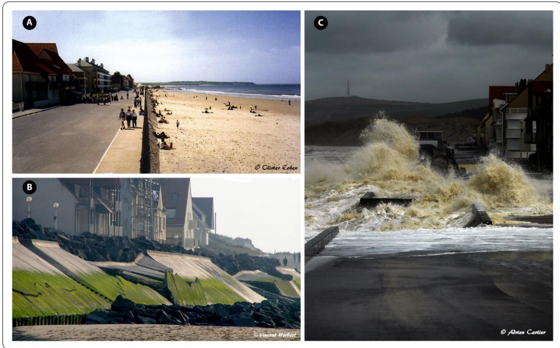
Photo I-4 : La digue de Wissant en 1998 (A) et en 2007 (B). Le niveau du sable s'est abaissé d'environ 8 m. C) Submersion de la digue lors de la tempête de mars 2010.
