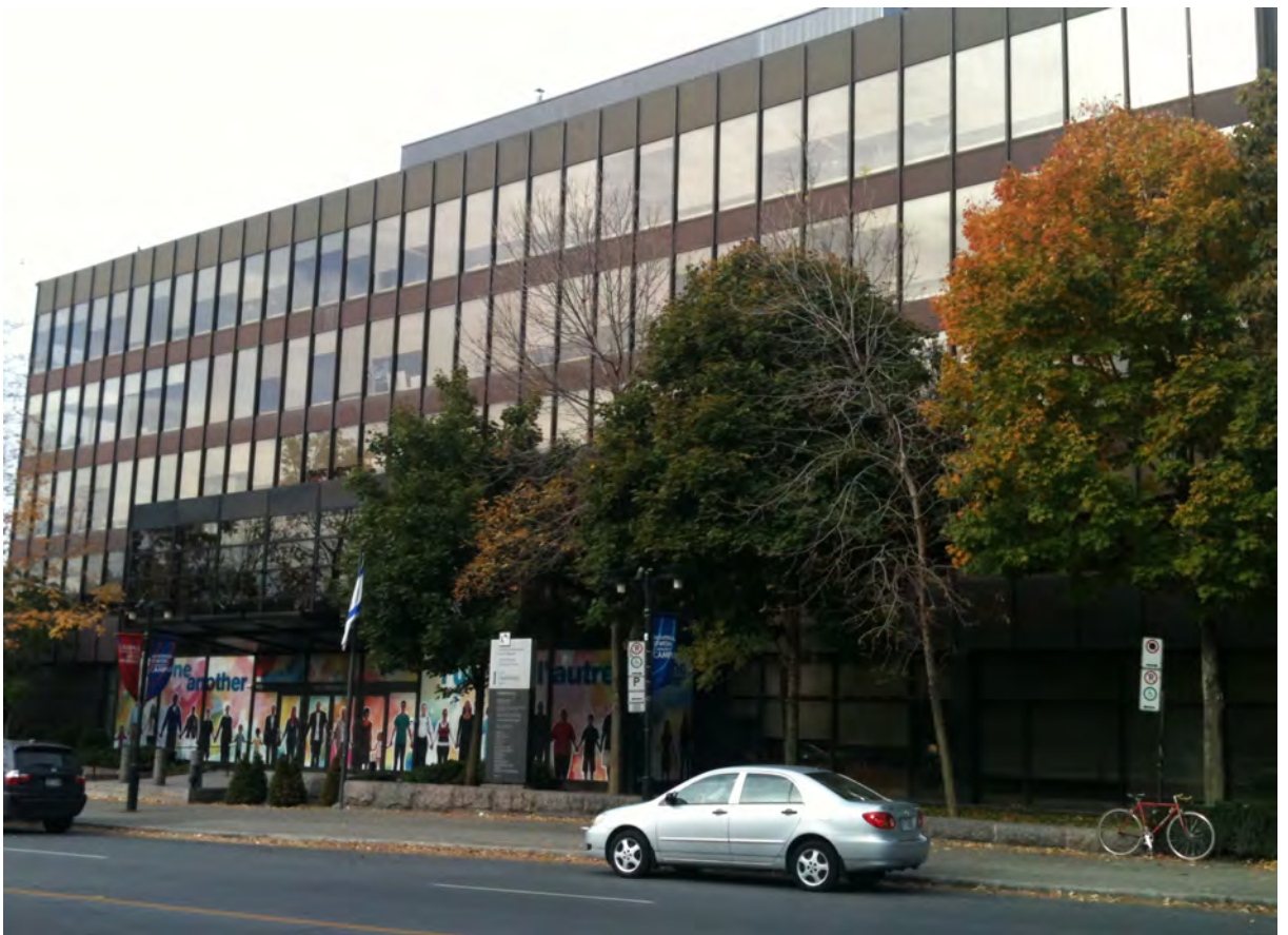
Le centre commémoratif de l'Holocauste de Montréal est situé au rez-de-chaussée. Cliché pris par l'auteur. Octobre 2010.
