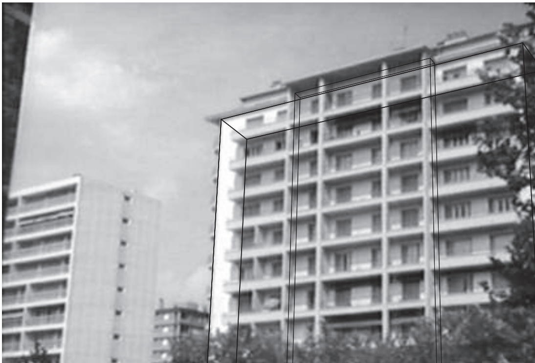
figure 55 Mise en place du volume général
