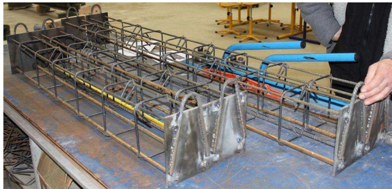
(a) Réalisation du ferrailage
