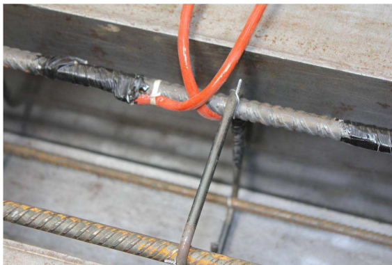
(b) Mise en place des jauges d'extensiométrie
