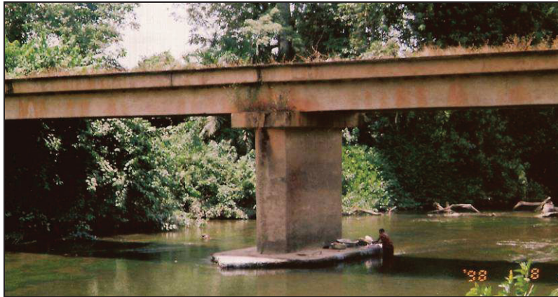
Photo 6 : Le pont de Ngongo
