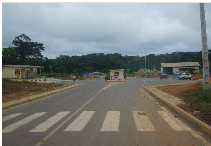
Photo 10 : Vue de la route à la frontière Gabon-Cameroun
