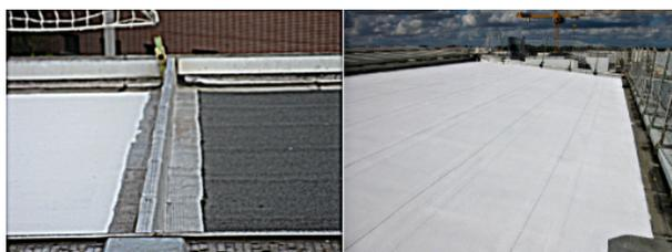
FIGURE 2.32 – Exemple de toit recouvert d'une peinture réflective (source : [Bozonnet *et al.*, 2011])
