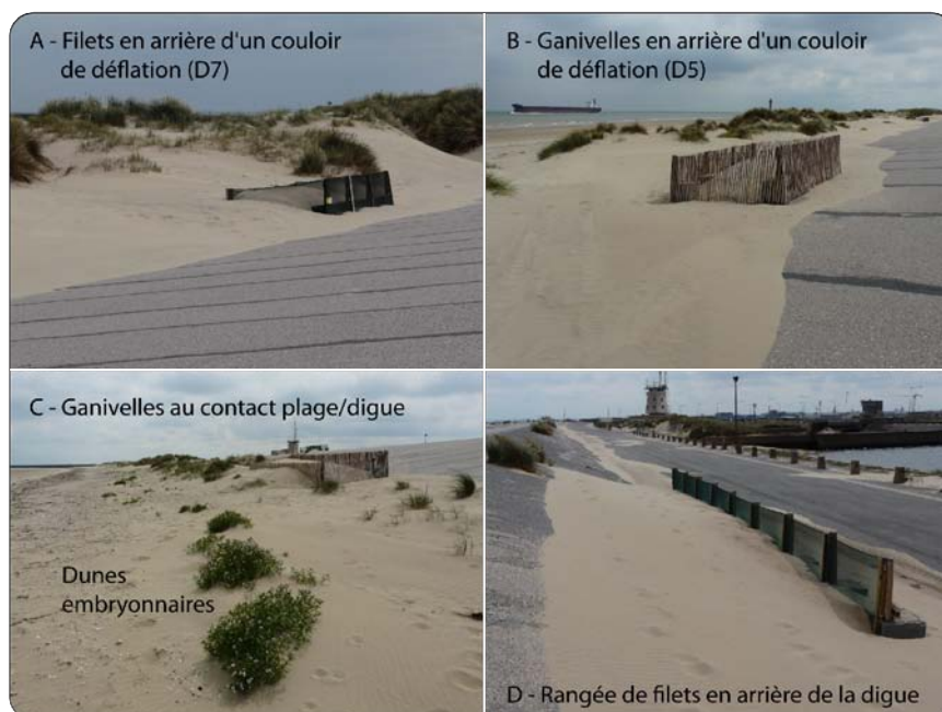
Figure 6.31 Photographie de 4 structures installées sur la digue : (A) filets synthétiques en arrière des dunes de pied de digue ; (B) ganivelles en arrière des dunes de pied de digue ; (C) Dunes embryonnaires à l'avant des ganivelles au contact plage/digue ; (D) rangée de filets située en arrière de la digue (clichés Tresca, 14.06.2011)
