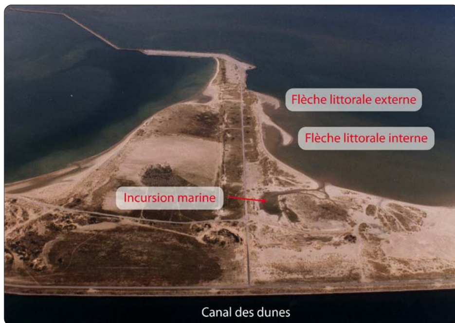
Figure 3.3. Cliché aérien de 1994 montrant une incursion marine au niveau du transect T14 ainsi que les deux flèches littorales et l'érosion au nord de la digue de Ruytingen (Photographie : Objectif Vidéo, 1994)
