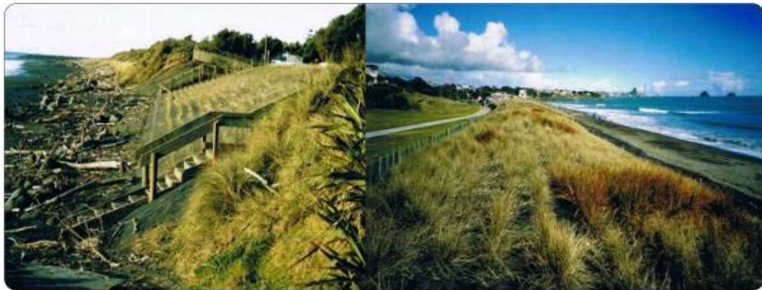
Figure 7.17. Exemple d'aménagements créés pour les usagers suite à la création d'un cordon dunaire artificiel à Okaura beach (Nouvelle-Zélande) : (A) passerelles pour piétons ; (B) plantations et clôture (Bergin et al., 2007)
