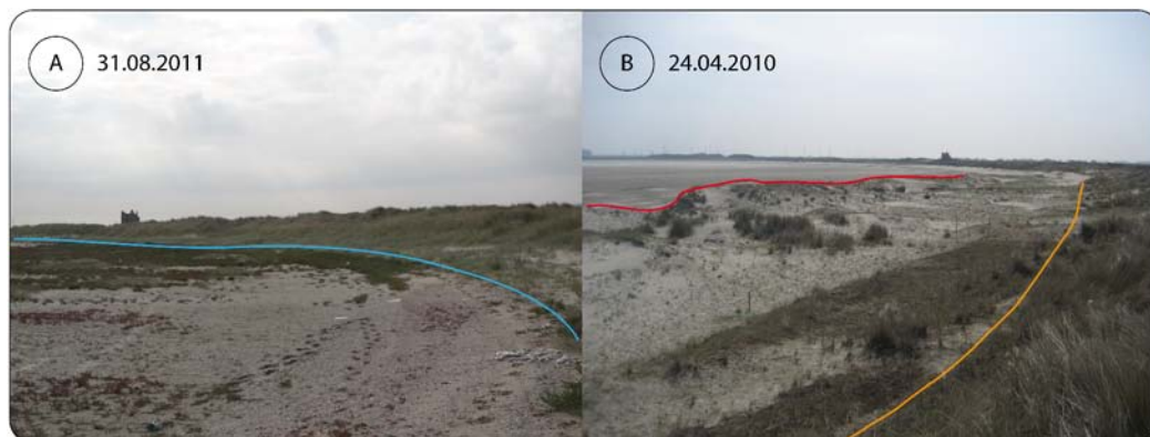
Figure 3.4. (A) En bleu, limite entre, à gauche la végétation recouverte à marée haute, et à droite, la végétation du versant dunaire (photo prise en direction du SE au niveau du transect 10) – (B) En rouge, le trait de côte actuel, et en jaune, le trait de côte avant 1997 (photo prise vers le SE au niveau du transect T5) (Clichés Tresca, 2010, 2011)
