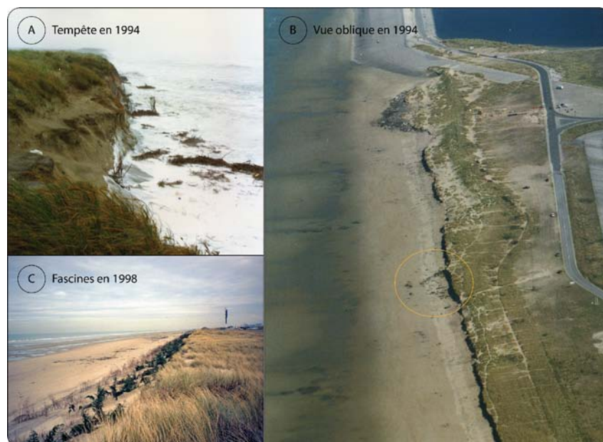
Figure 3.7. Photographies prises entre les transects T70 et T85 : (A) Sur le terrain lors d’une tempête en 1994 aux environs de T75 (Cliché GPMD, 1994) ; (B) Vue aérienne oblique suite à la tempête de 1994, on peut voir les restes de fascines qui ont été déblayées par la mer (Cliché GPMD, 1994) ; (C) Exemple de fascines implantées sur le haut de plage en 1998 près du transect T70 (Cliché Ruz, 1998).
