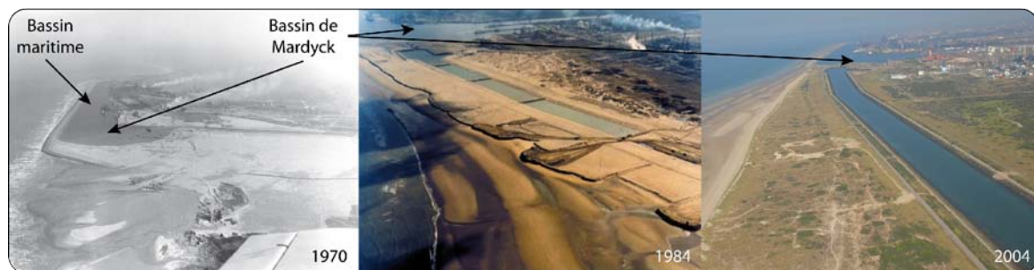
Figure 1.7 Photographies prises avant (1970), pendant (1984) et après (2004) le creusement du canal des dunes (Sources : Archives GPMD, 1970 ; PAD, 1984 ; PAD, 2004)
