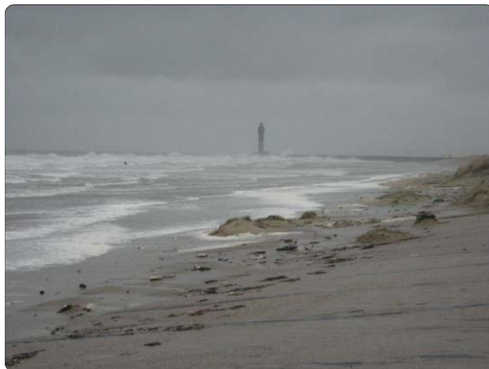
Figure 7.15. Emplacement de la structure de ganivelles situées au contact plage/digue lors d'une tempête en février 2010 (Cliché Tresca, 28.02.2010)
