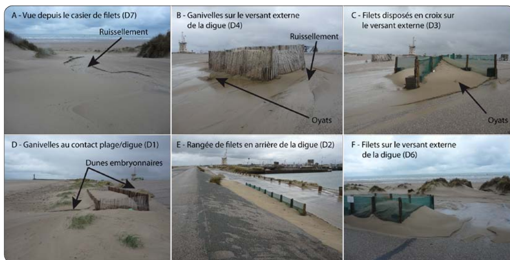
Figure 6.38. Photographies de 6 structures de captage du sable sur la digue du Braek (clichés Tresca, 16.12.2011)
