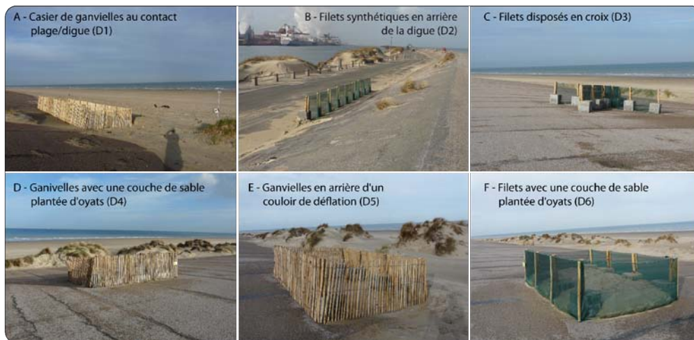
Figure 6.26. Photographie de 6 structures installées sur la digue le 14.02.2011 (cliché Tresca)
