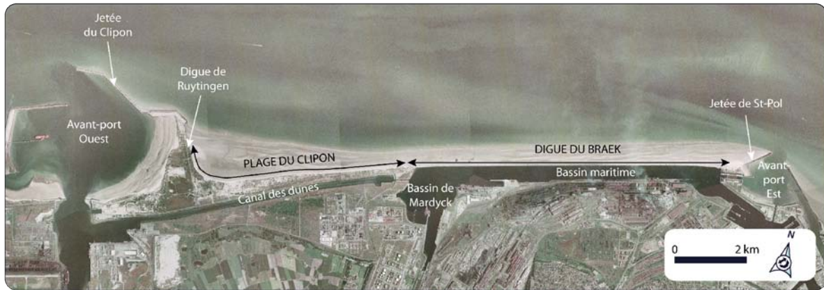
Figure 1.2 Délimitation du site d'étude (Source de la photographie aérienne : Ortholittorale 2000)
