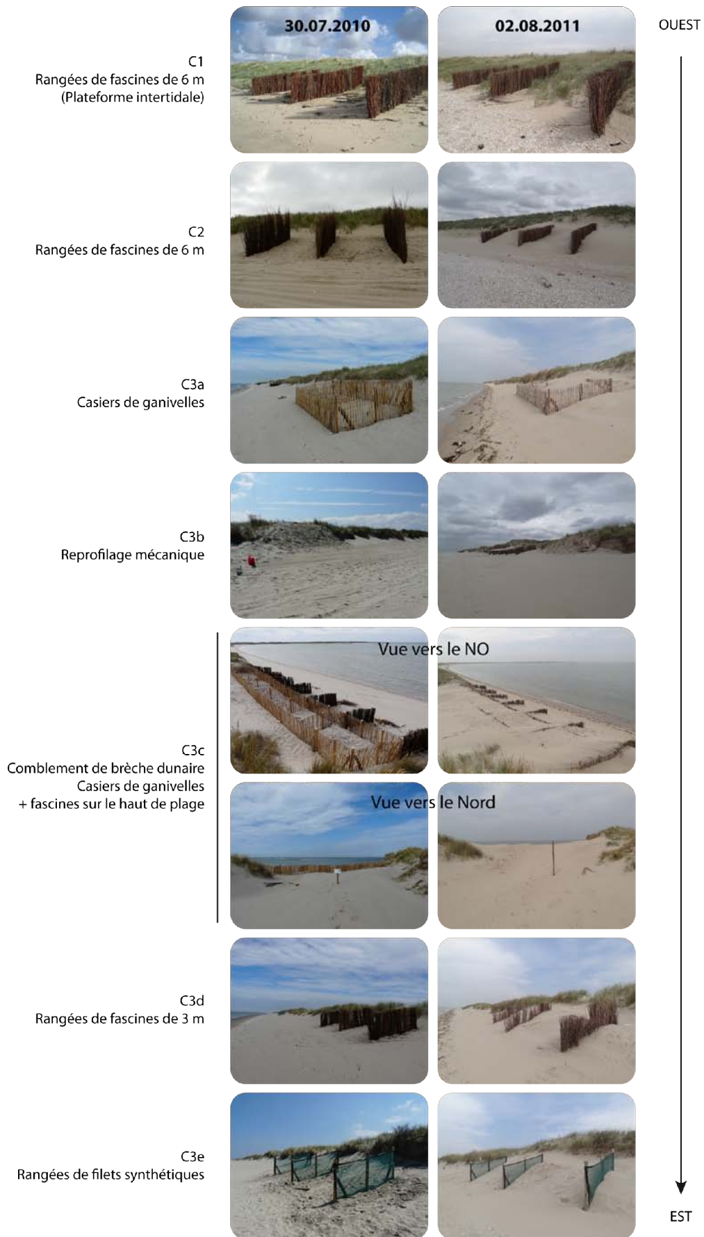
Figure 6.21 Photographies des structures de captage du sable sur la plage du Clipon le 30.07.2010 et le 02.08.2011
