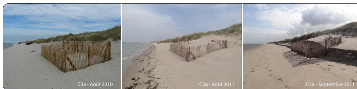
Figure 6.17 Photographies de la structure en casiers de ganivelles (C3a) : au début du suivi (août 2010), avant (août 2011) et après (septembre 2011) l'épisode d'érosion du haut de plage du 31 août 2011 (clichés Tresca)
