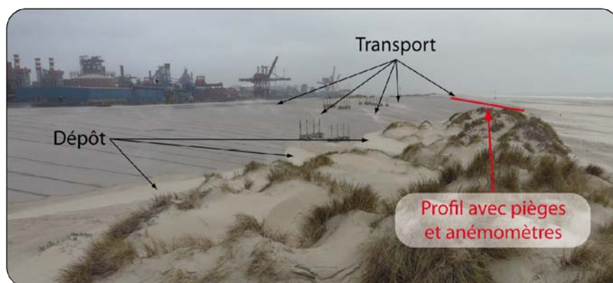
Figure 5.23. Photographie de terrain du 04.02.2011 montrant le transfert du sable de l'arrière de la digue vers le versant externe et le haut de plage (cliché Tresca, 2011)
