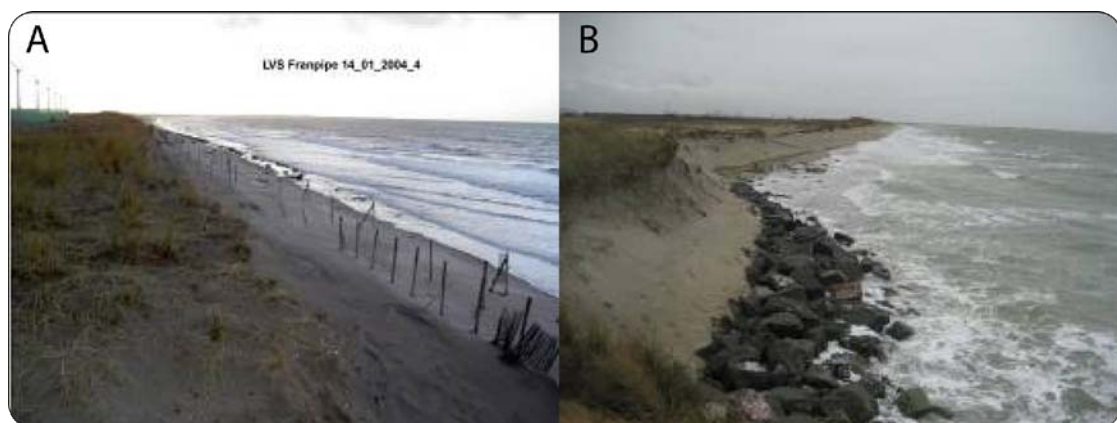
Figure 7.19. (A) Structures de captage du sable détruites par la mer au niveau du profil S2 (falaise sableuse) en 2004 (cliché Port Autonome de Dunkerque, 2004) ; (B) Formation d'une microfalaise d'érosion au niveau du profil S2 en février 2010 (cliché Tresca 2010)
