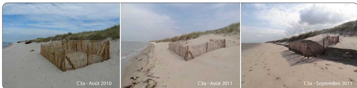
Figure 6.17 Photographies de la structure en casiers de ganivelles (C3a) : au début du suivi (août 2010), avant (août 2011) et après (septembre 2011) l'épisode d'érosion du haut de plage du 31 août 2011 (clichés Tresca)
