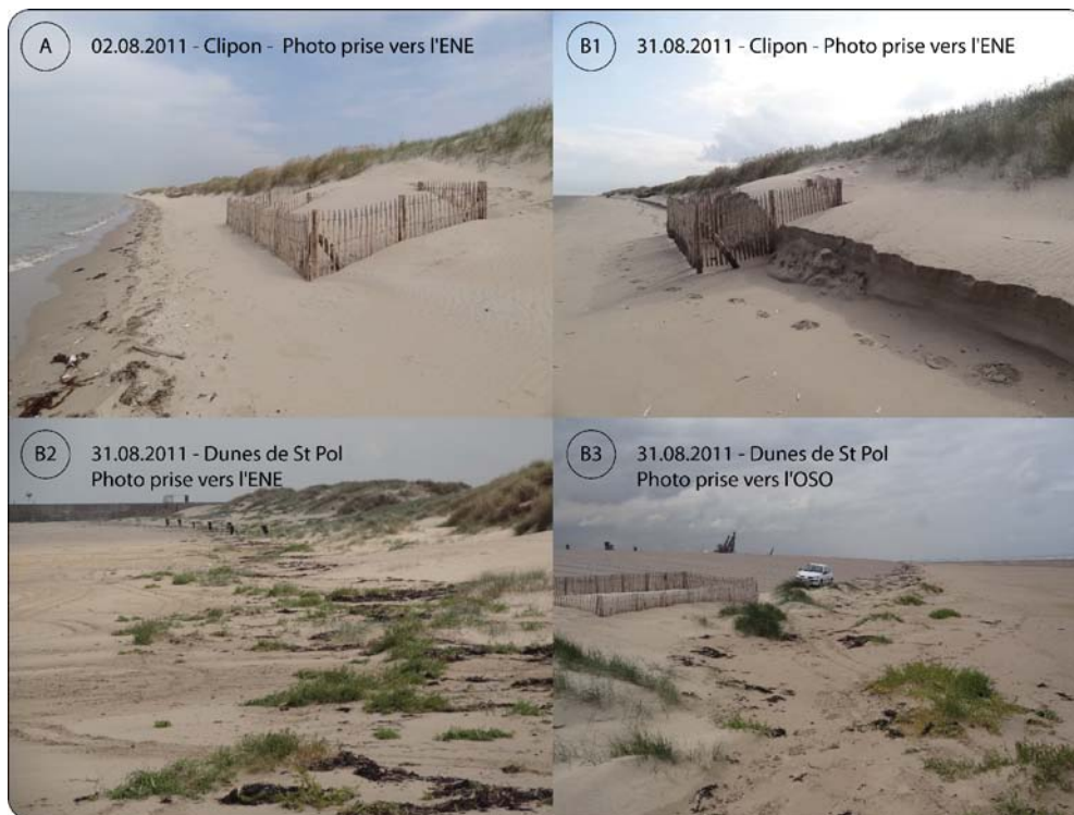
Figure 4.20. Photographies prises sur la plage du Clipon (A) avant et (B1) après l'épisode d'érosion du haut de plage du 30/08/2011, ainsi que sur la plage au niveau du profil D7 à l'Est de l'UG4 vers l'Est (B2) et vers l'Ouest (B3) après l'érosion au Clipon (Tresca, 2011)
