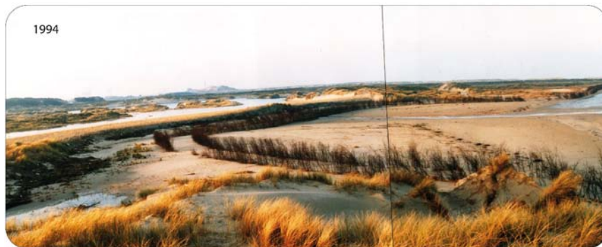
Figure 3.5. Incursion marine et rideaux de fascines longitudinaux en 1994 dans les dunes du Clipon au niveau des transects T14 et T15 (Cliché archives GPMD, 1994).
