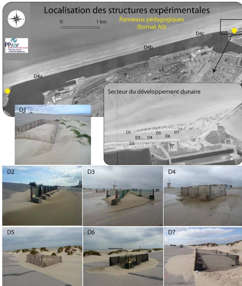
Figure 2.2. Localisation des structures expérimentales de captage du sable sur la digue du Brack.
