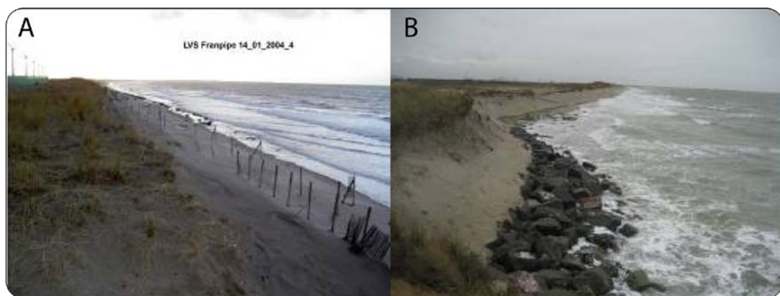
Figure 7.19. (A) Structures de captage du sable détruites par la mer au niveau du profil S2 (falaise sableuse) en 2004 (cliché Port Autonome de Dunkerque, 2004) ; (B) Formation d'une microfalaise d'érosion au niveau du profil S2 en février 2010 (cliché Tresca 2010)
