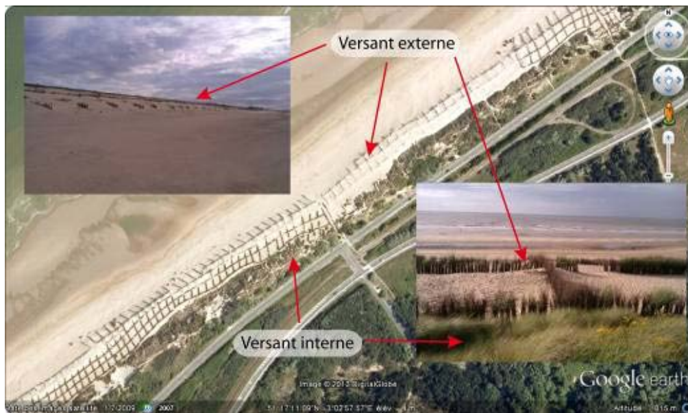
Figure 7.21. Photographies illustrant un projet de développement dunaire par le recouvrement de casiers de fascines sur le versant externe de la dune bordière De Haan, Belgique (photos terrain Tresca, 2012 ; Photographie aérienne © Google Earth)
