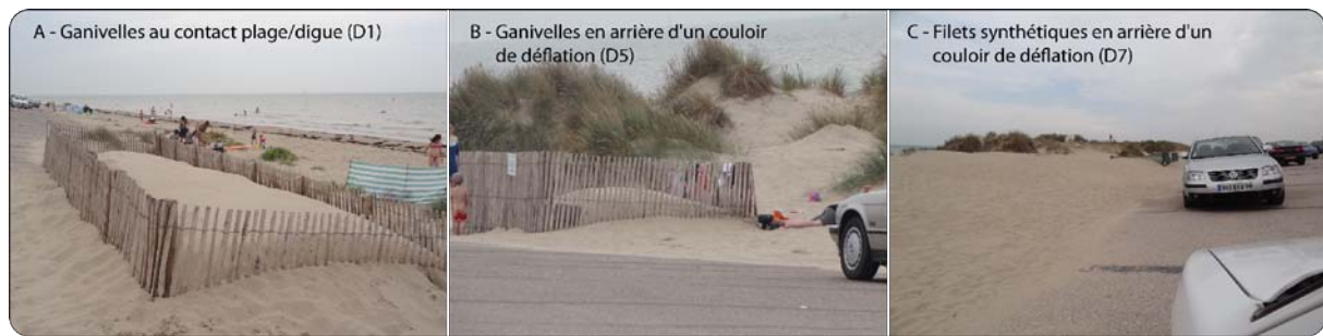
Figure 6.35 Photographies illustrant la fréquentation de la digue du Braek en été au niveau (A) des ganivelles au contact plage/digue (D1) ; (B) des ganivelles et (C) des filets synthétiques installés en arrière de couloirs de déflation (clichés Tresca, 02.08.2011)
