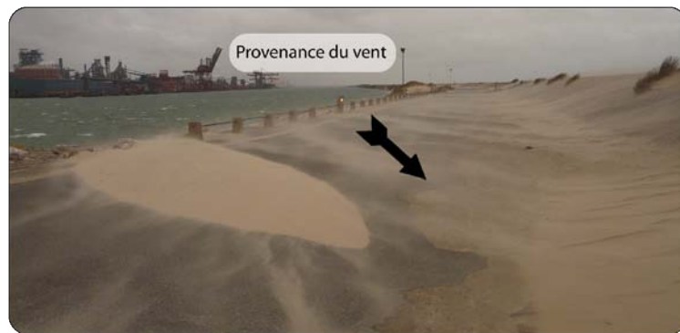
Figure 5.36. Photographie prise vers l'Ouest sur la route située en contrebas du versant interne de la digue (côté bassin) lors de l'expérimentation du 05 février 2011 menée lors de vent de SO. Le sable en bordure de bassin est rabattu sur la route puis sur le versant interne de la digue et franchit le sommet de l'ouvrage (Tresca, 2011)
