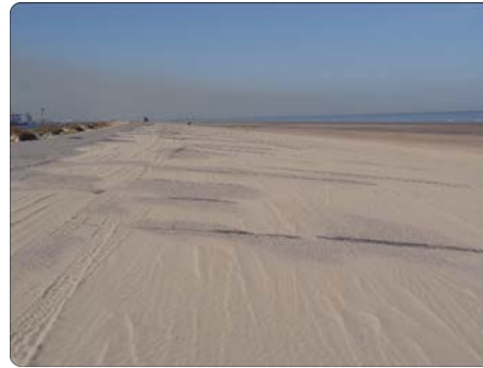
Figure 4.9. Photographie au niveau du profil D5, illustrant la digue recouverte de sable en provenance des dunes de pied de digue (Cliché Tresca, 27.03.2011)
