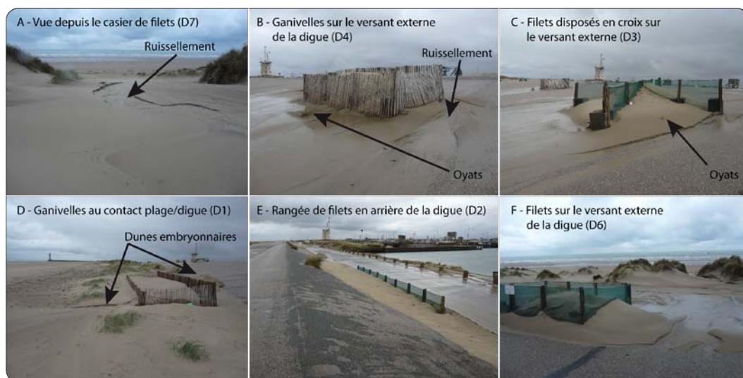
Figure 6.38. Photographies de 6 structures de captage du sable sur la digue du Braek (clichés Tresca, 16.12.2011)
