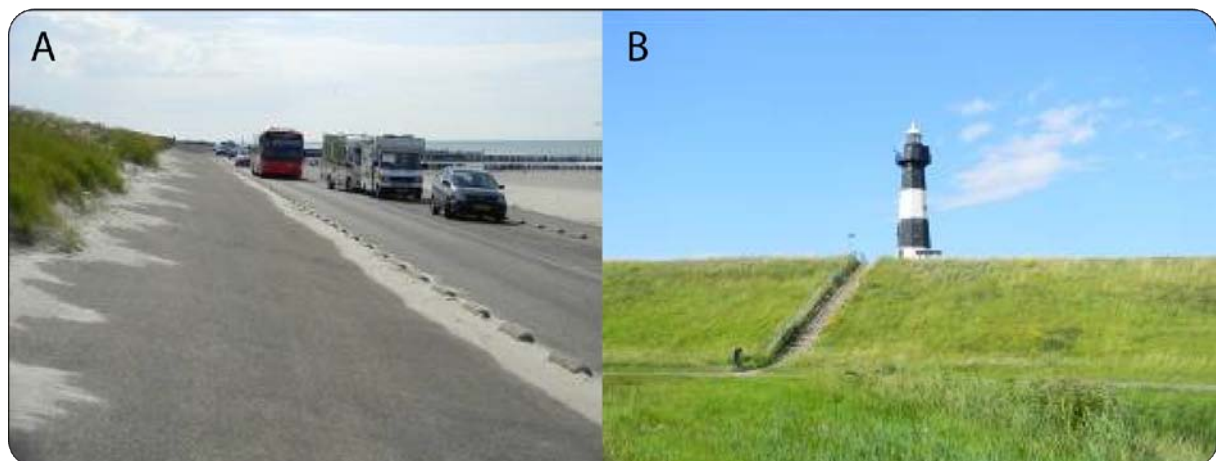
Figure 7.23. Aménagement d'une digue en asphalté près de Breskens, Pays-Bas : (A) versant externe et (B) versant interne).
