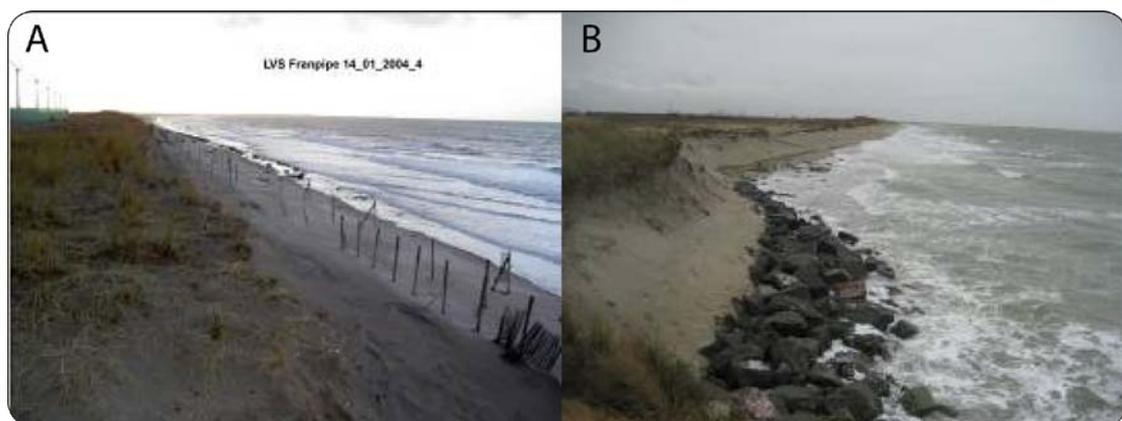
**Figure 7.19. (A) Structures de captage du sable détruites par la mer au niveau du profil S2 (falaise sableuse) en 2004 (cliché Port Autonome de Dunkerque, 2004) ; (B) Formation d'une microfalaise d'érosion au niveau du profil S2 en février 2010 (cliché Tresca 2010)**
