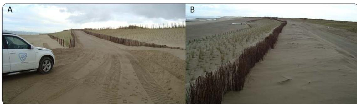
Figure 7.18. Projet de protection du littoral mené par le « Waterschap Scheldestromen » sur la côte sud des Pays-Bas : l'accès à la plage est canalisé par des haies de fascines qui empêchent le piétinement au niveau des zones fixées par les oyats (photographies A. Provoost, 2010)
