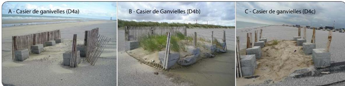
**Figure 6.24 Photographies illustrant les détériorations au niveau des structures installées au centre (A & B) et à l'Ouest (C) de la digue du Braek (clichés Tresca, 12.05.2011)**
