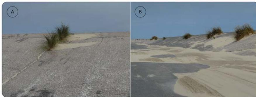
**Figure 3.21. Photographies de la naissance de dunes sur la digue par l'exploitation des fissures dans l'enrobé (Clichés, Tresca, 28/07/2010)**
