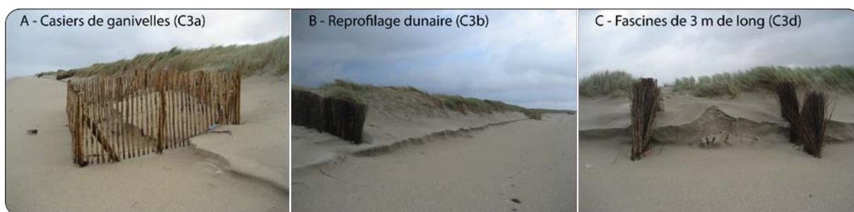
**Figure 6.7 Photographies des structures C3a, C3b et C3d le 28.09.2010 (cliché Tresca)**
