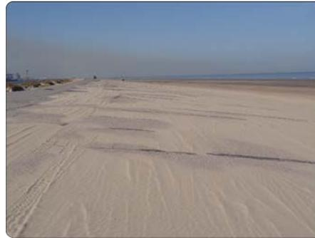
Figure 4.9. Photographie au niveau du profil D5, illustrant la digue recouverte de sable en provenance des dunes de pied de digue (Cliché Tresca, 27.03.2011)
