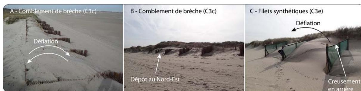
**Figure 6.14 Photographies de la structure de comblement de brèche (C3c) (A & B) et des filets synthétiques (C) illustrant la déflation au dessus des structures (clichés Tresca, 11.04.2011)**
