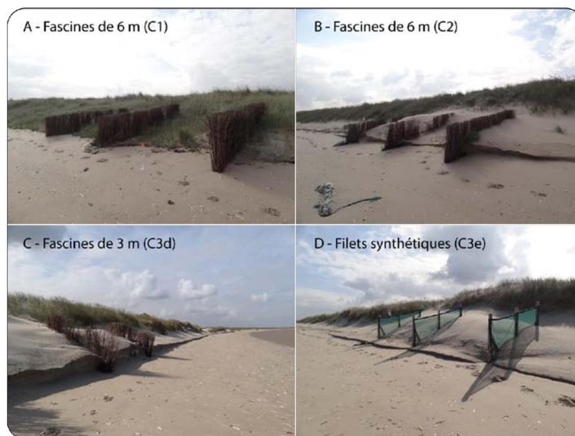
**Figure 6.19 Photographies des structures C1 – fascines de 6 m (A), C2 – fascines de 6 m (B), C3d – fascines de 3 m (C) et C3e – filets synthétiques (D) le 31.08.2011 (clichés Tresca)**
