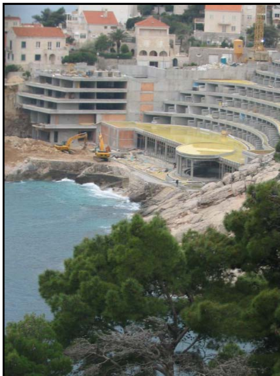
Photographie 15 : Construction en 2007 d'un hôtel au nord de Dubrovnik (cliché de l'auteur, avril 2008)
