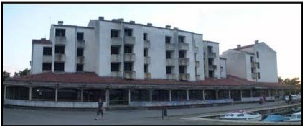
Photographie 19: Equipement hôtelier à l'abandon à Červar-Porat, exemple du manque actuel d'investissement (Source : google earth- août 2010) Construit durant la période yougoslave, de nombreux équipements hôteliers sont désormais à l'abandon. Situé au nord de Poreč, dans la ville-nouvelle de Červar-Porat, créée pour les besoins du tourisme, cet hôtel est proposé aux investisseurs mais ne correspond plus aux exigences actuelles des touristes (absence de piscines, d'espaces verts...). Des promoteurs immobiliers pourraient pourtant tirer profit de sa localisation en le transformant en appartements pour résidences secondaires.
