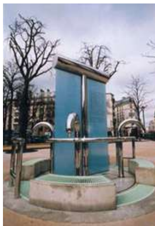
Figure 10 : Fontaine publique prévue pour distribuer l'eau de la nappe de l'Albien à la population parisienne en cas de pollution NBC.
