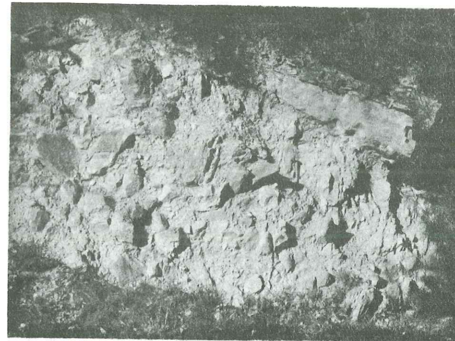
Photo 33. Pseudo-brèche du toit du Cénomaniens; route Entreachaux-St-Marcellin-les-Vaisors.
