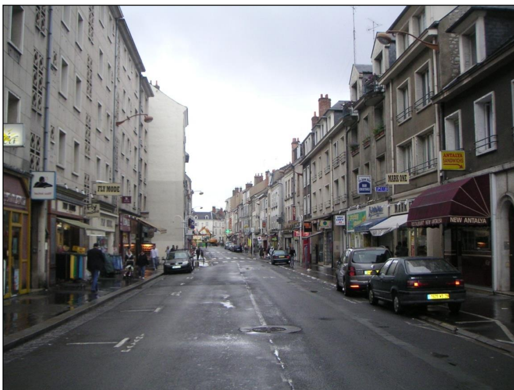
Photo 6. Vue de la rue des Carmes à Orléans depuis l'est avec au premier plan à gauche la partie reconstruite et au second plan la partie ancienne, plus étroite et promise à la démolition 1
