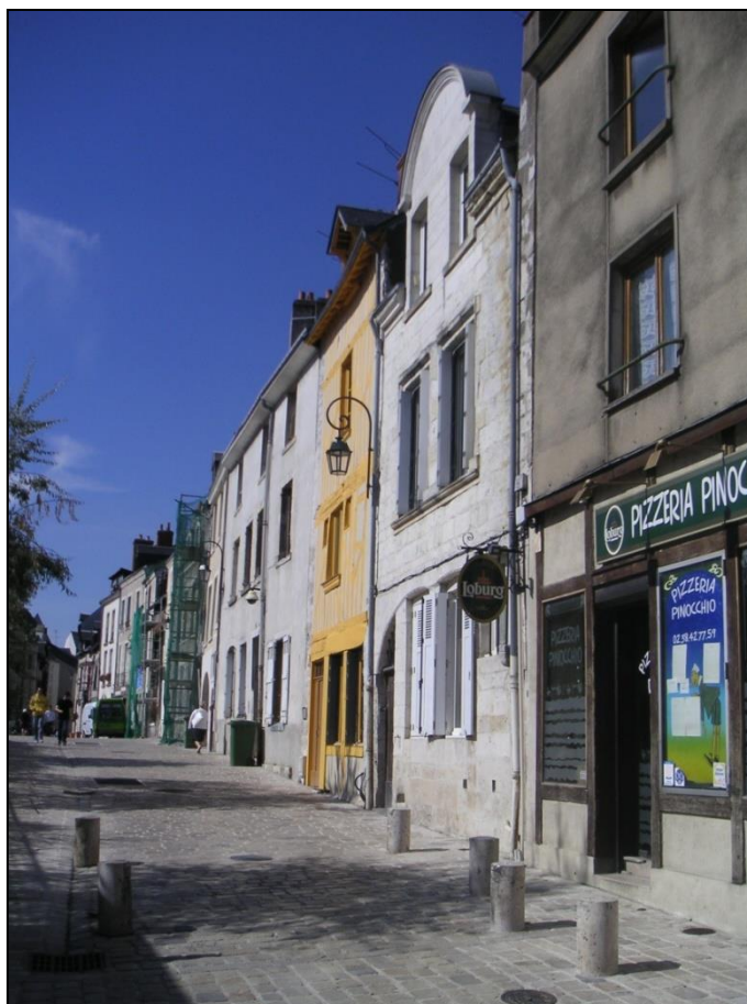
Photo 3. La requalification des espaces publics et la restauration des façades à « pan de bois » : deux éléments d'une action complète en centre ancien 1
