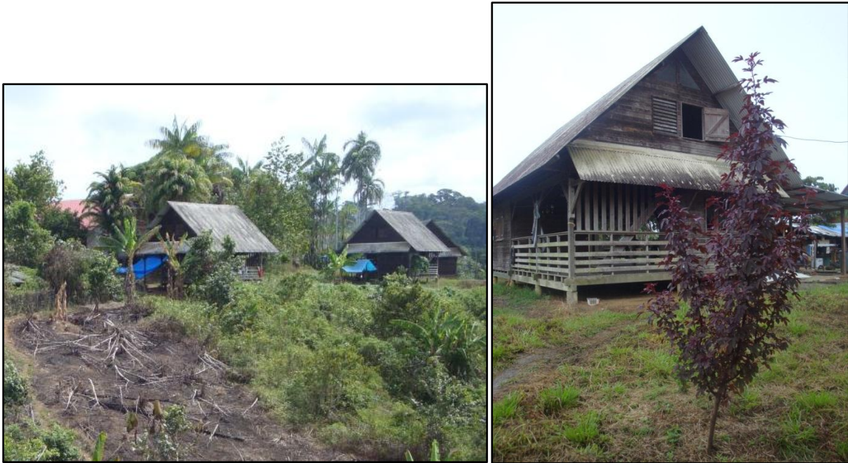
Photo 9. Les logements sociaux du bourg de Camopi
