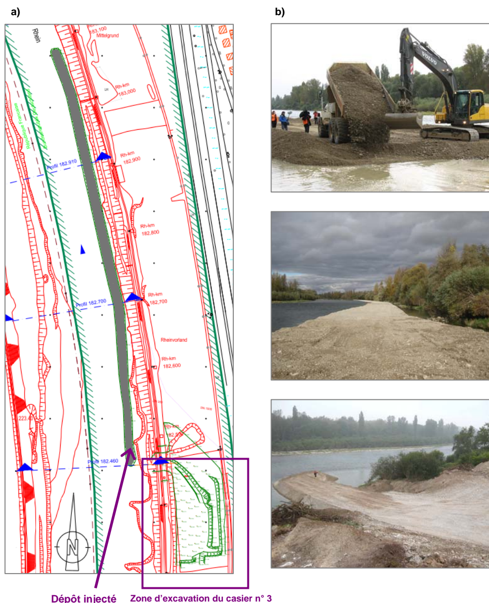
Figure 3.6 : a) Extrait du plan de recollement de Vinci Construction indiquant la position du dépôt injecté (04/11/10). Les sédiments ont été introduits entre les PK 182,46 et 183,08. b) Vues du chantier (clichés F. Arnaud, 2010)
