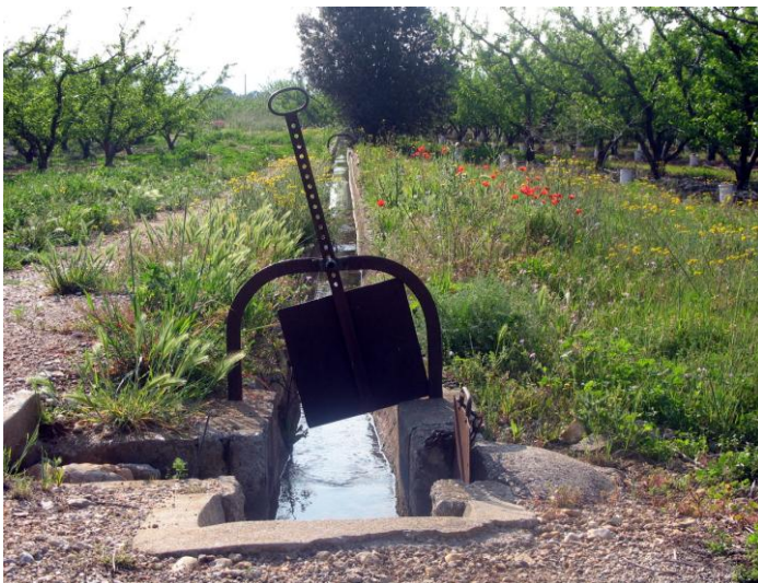
Photo 10 : Réseau d'irrigation, St-Jean-de-Fos © ARH 2007
