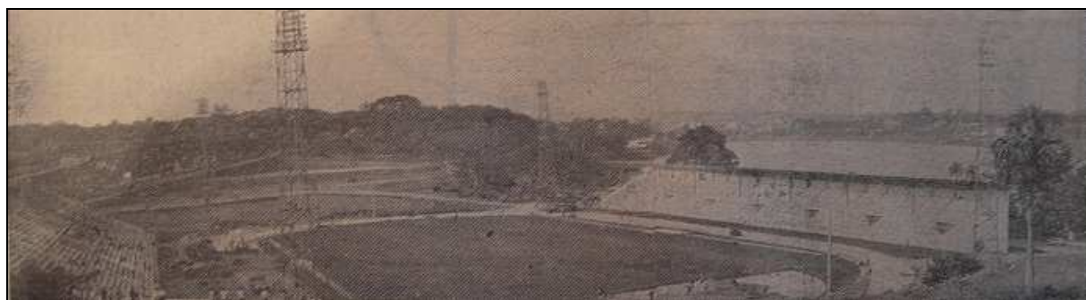
90. Le Stade Géo-André après les travaux de remise en état, Fraternité Matin , Les Jeux d'Abidjan, 22/12/1961, n°139, p.7, (Archives ANS).
