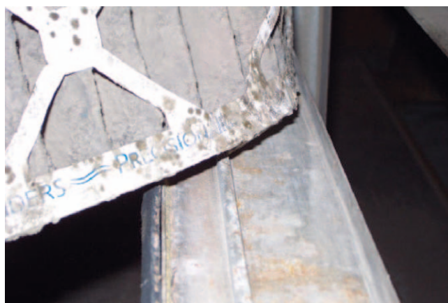
Figure 2. Photographie de moisissures qui se sont développées sur un filtre mécanique installé dans une centrale de traitement de l'air. Noter que les colonies fongiques prolifèrent à la surface du filtre et le long des fentes du cadre supportant le filtre.
