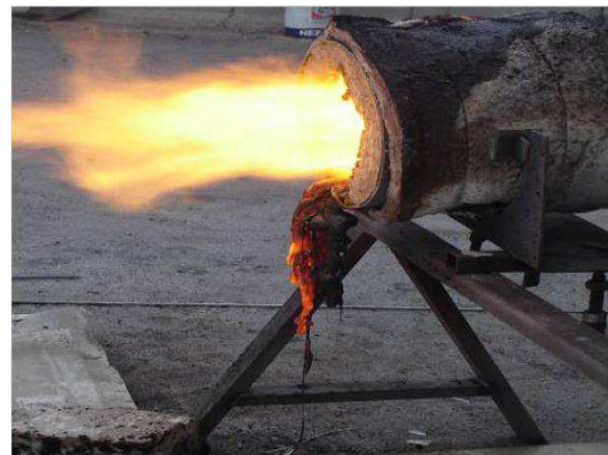
Figure IV-108 Réacteur de TKEnergy- zone haute température
